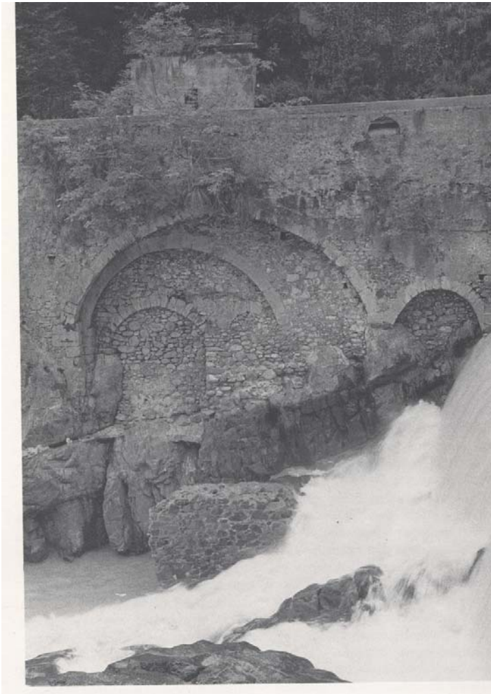
Figura n.24: archi di sostegno per la strada sotto i dirupi di Cornello dei Tasso (L'arco inferiore è veneto, quello mediano e austriaco, il superiore è dagli inizi del'900) da Pesenti, Carminati 1988, p.272
