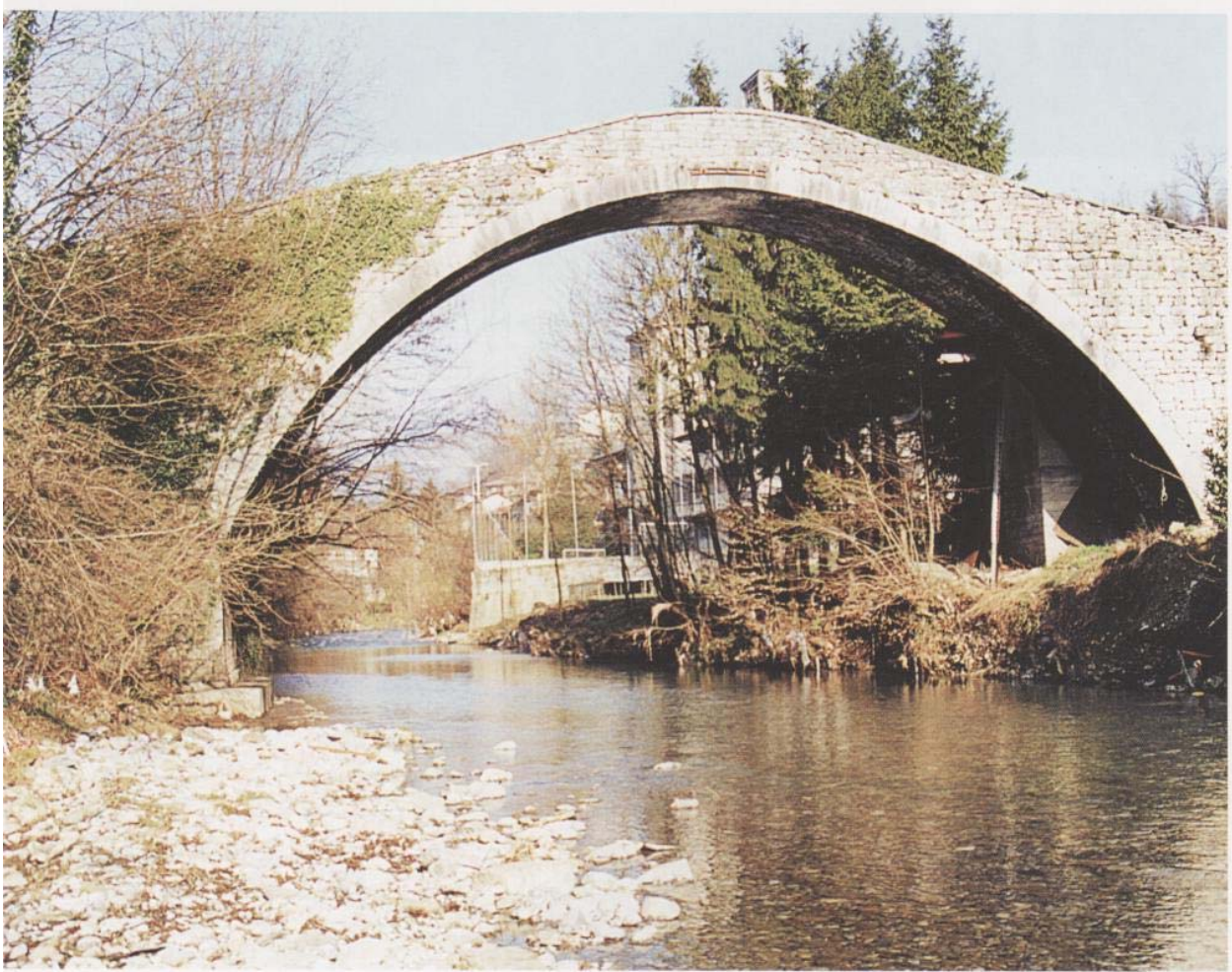
Figura n.30 : il ponte di Berbenno, da Adorati,Lorenzi 2001,scheda 'Berbenno-Ponte medievale'
