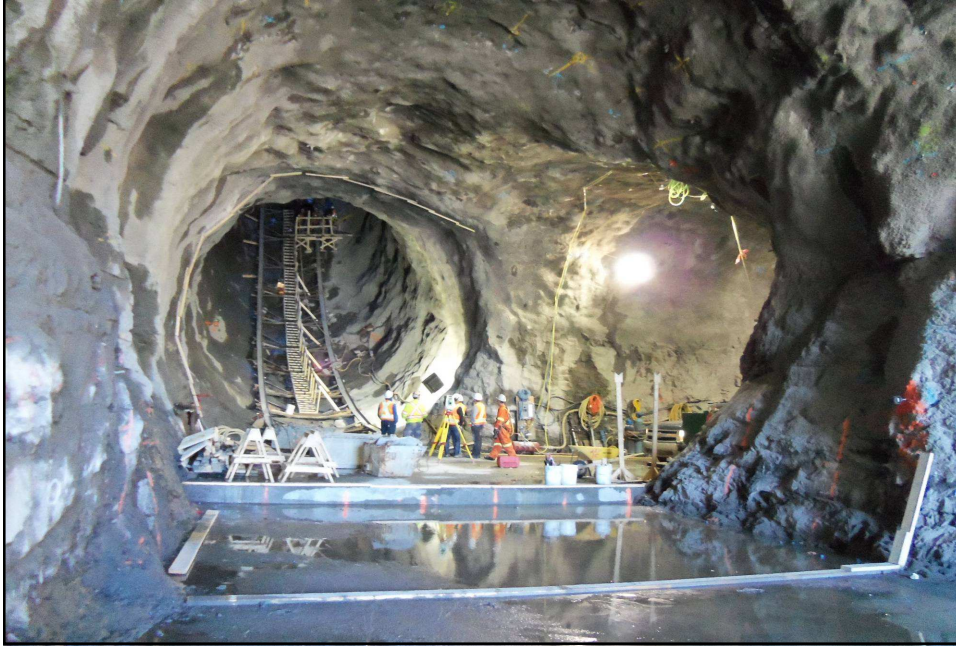
Avancement des travaux Coude inférieur - Conduite forcée Groupe 12
