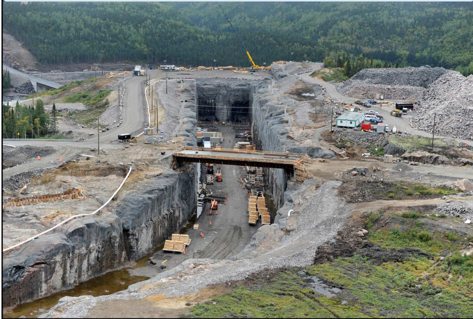
Avancement des travaux Canal d'améné et Prise d'eau
