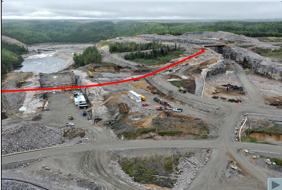
Avancement des travaux - Vue d'ensemble barrage Évacuateur de crues et canal d'aménée
