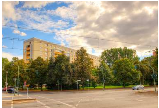
F13 Blick Greifswalder Straße Richtung Gürtelstraße
