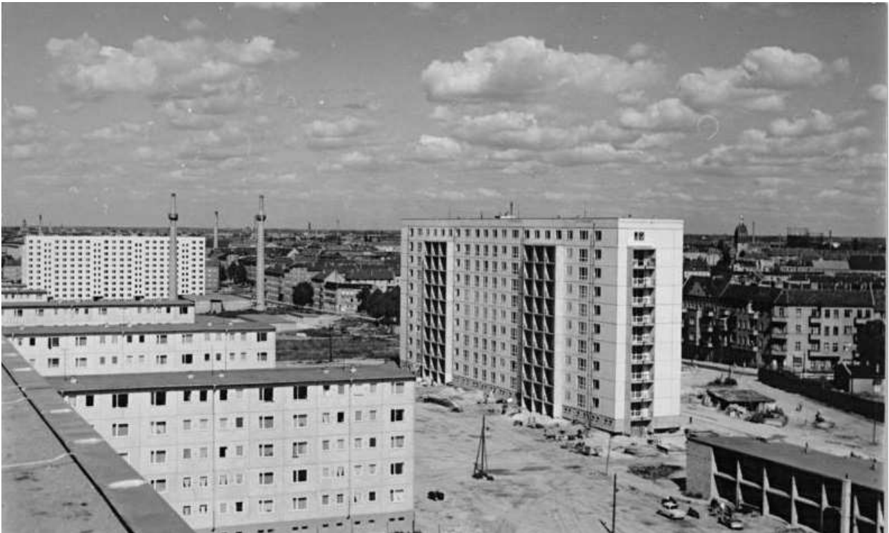
Abb. 6: Michelangelostraße/Gürtelstraße während der Bauzeit
