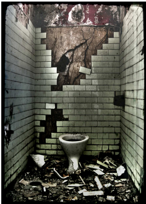
Barra (NA) Interni scuola abbandonata , 2008
