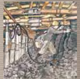
昭和30年以後鉄柱、平型コンベヤ採掘 (麻生の記憶遺産より)
