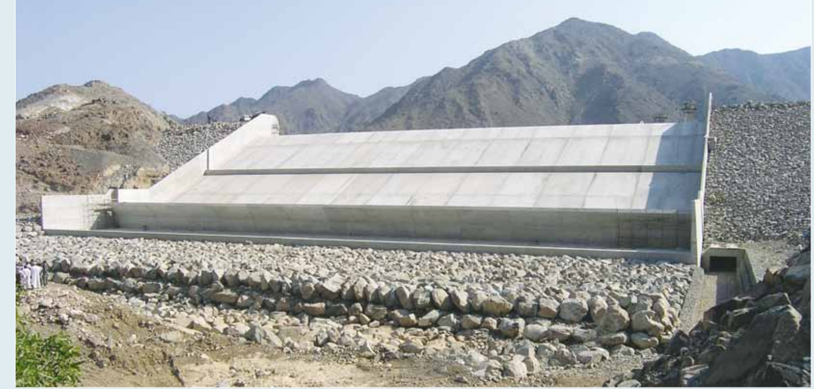
الواجهة السفلية لمفيض سد وادي الصاروج
