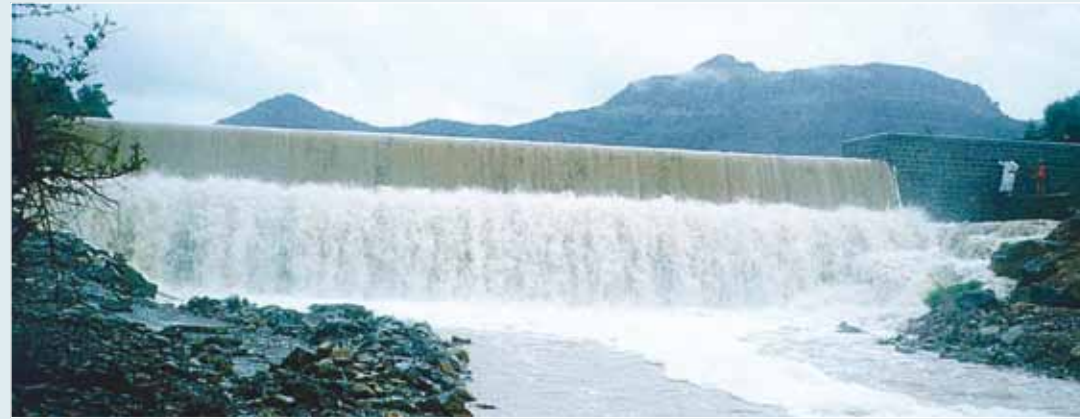
تدفق المياه عبر مفيض أحد السدود
