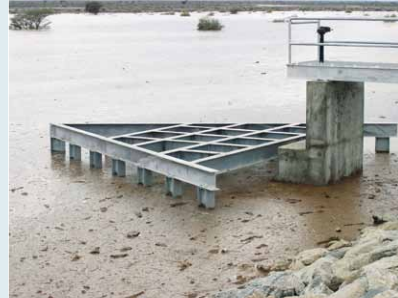
برج التحكم لتصريف المياه المحتجزة
