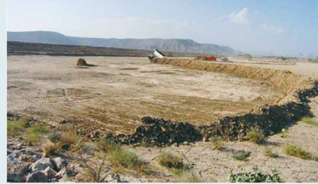
عملية إزالة الترسبات الطينية من أحد سدود التغذية الجوفية
