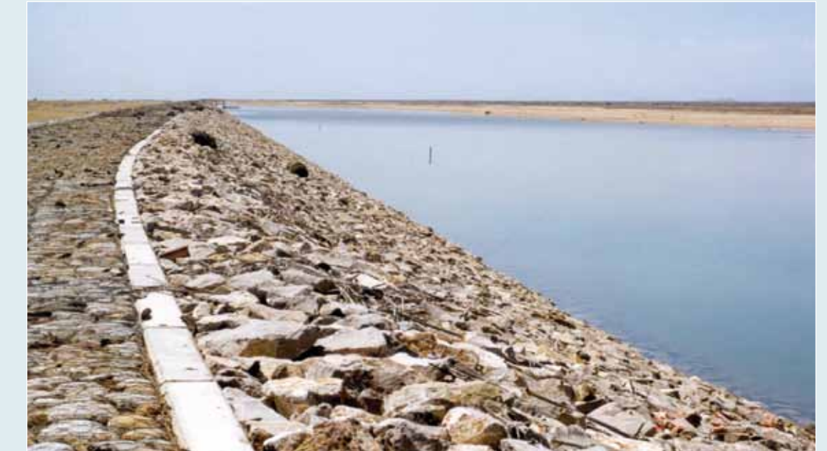
بحيرة تجمع مياه سد وادي الفليح (بركاء)
