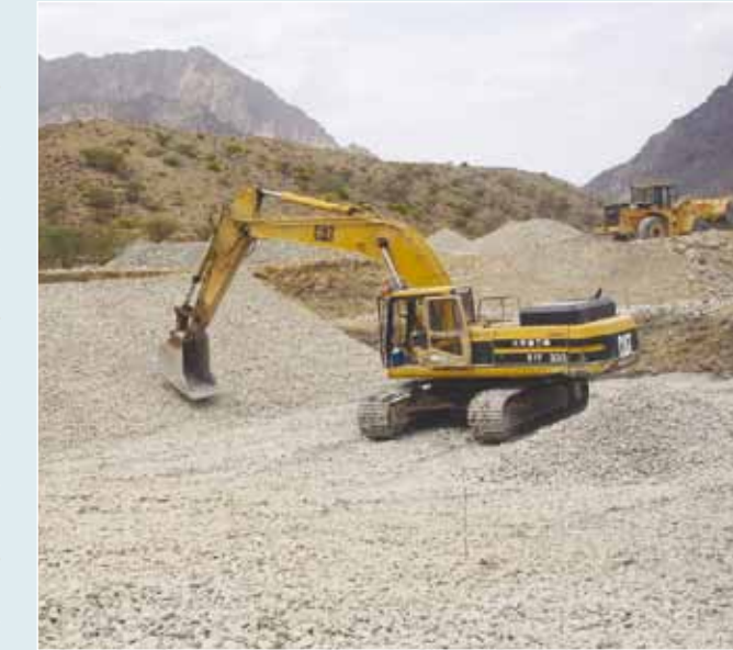
أعمال الإنشاء لأحد سدى وادي السحتن
