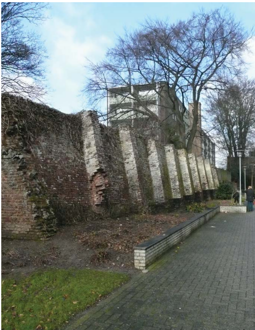
Schoormuur gezien vanuit het zuidoosten, foto 2009
