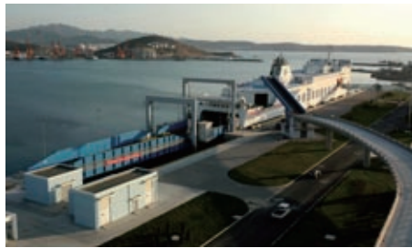
中铁四局承建的烟大铁路轮渡工程，创钢梁设计先河，获鲁班奖和詹天佑奖
