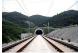
中铁四局承建的武广客运专线牛轭湾隧道
