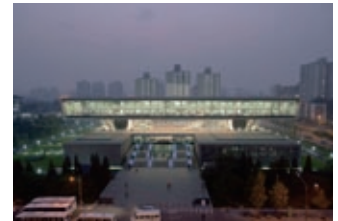
中铁建工集团承建的国家图书馆二期工程
