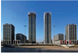
中铁建工集团开发的大连诺德大厦
