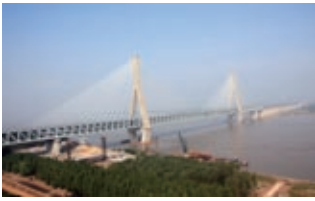
中铁大桥局承建，中铁科工集团参建的武汉天兴洲长江大桥
