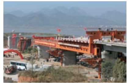
中铁四局自主研制的900吨移动模架造桥机获得国家多项专利
