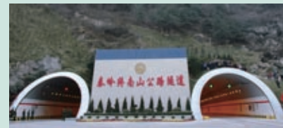
中铁五局承建的秦岭终南山隧道
