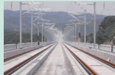
中铁七局承建的郑西客运专线无砟轨道工程
