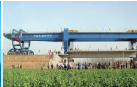
中铁科工集团研制的JQ900A型箱梁架桥机
