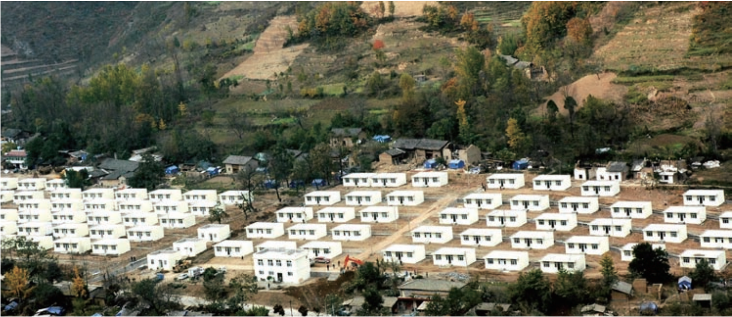
中铁一局援建的震区李家庄安置房
