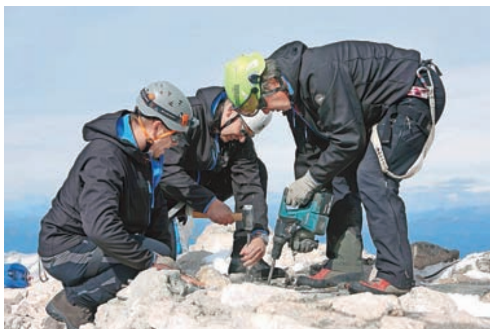
... kjer so sodelovali pri namestitvi stolpa na nove temelje in pričvrstitvi na štiri jeklenice.
