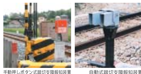
手動押しボタン式踏切支障報知装置 自動式踏切支障報知装置
