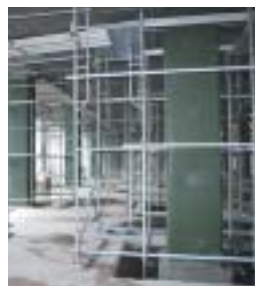
耐震補強工事
