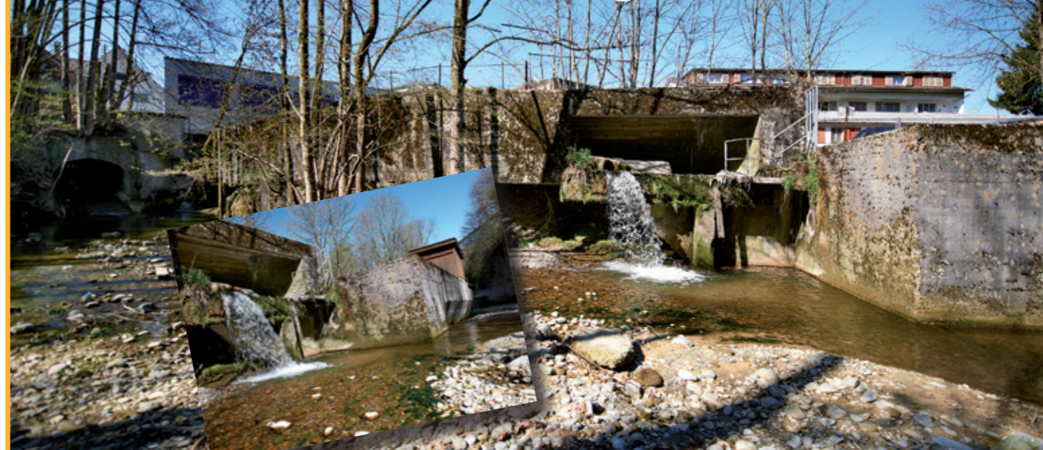
Das alte, zu kleine Rückhaltebecken im Töbéli Flawil. Bei Regen strömte hier viel Abwasser direkt in den Goldbach und von dort in die Glatt.
