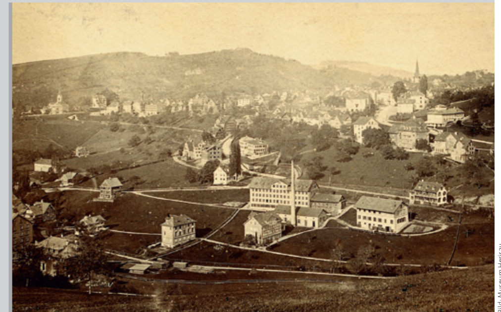
Läutete den Niedergang ein: Fabrik des Textilindustriellen Locher, 1857/58 unweit der Glatt-Mühlen erstellt – mit kohlenbetriebener Dampfturbine, ohne Bach und auf der grünen Wiese.
