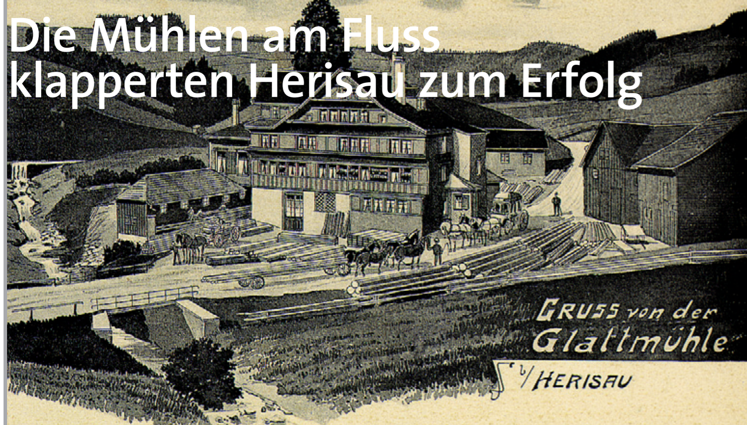
Die «Glattmühle» in vollem Betrieb ungefähr 1900. Der grosse Betrieb lag weit über Herisau unweit der Quelle der Glatt. Abbildungen wie diese sind selten. Gewerbegebäude waren damals – und sind ja heute noch – selten Objekt künstlerischer Darstellungen.
