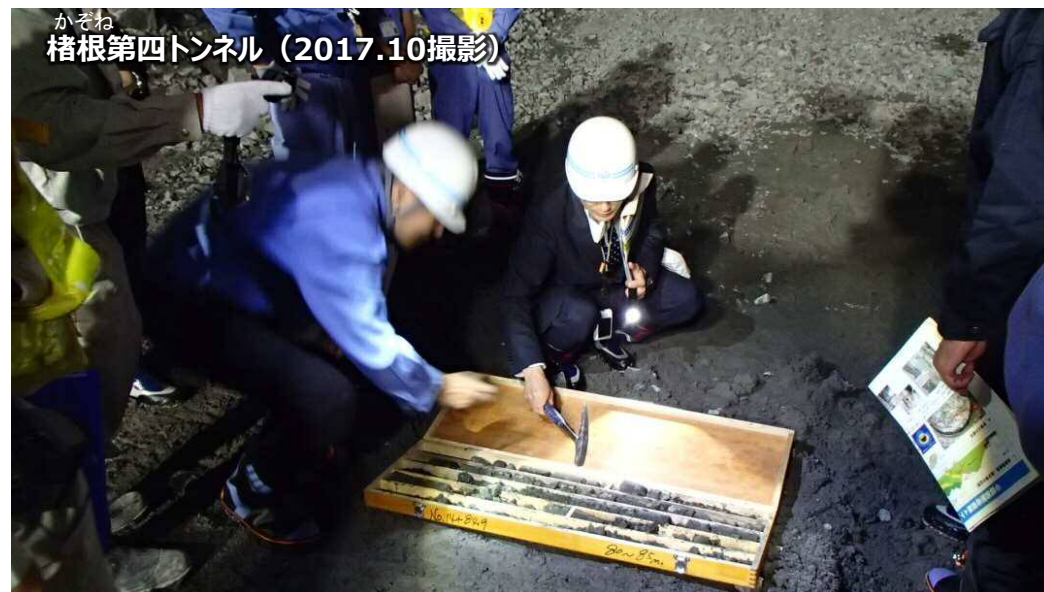
ボーリングコアの確認
