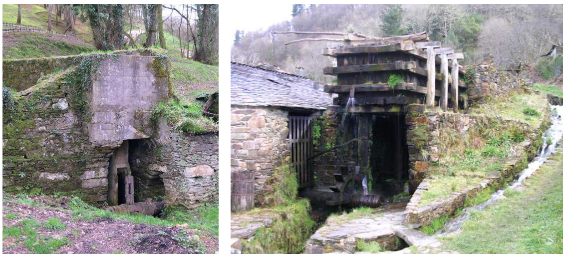
Aspecto exterior do banzado: esquerda, en pedra, Mazo da Fraga; Dereita, en madeira, Mazonovo, en Santalla de Ozcos.
