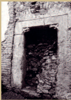
Gotický portál, odhalený ve zdivu budovy špýcharu asi v roce 1971
