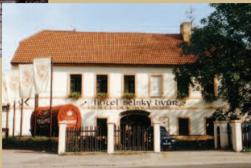
Bývalý Koukalův statek po rekonstrukci, 2008
