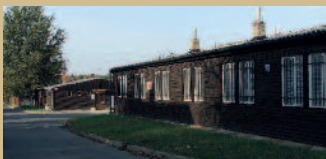
Sídlo úřadu Městské části Praha – Horní Měcholupy v Ovesné ulici, rok 1993
