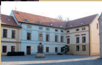
Dolejší mlýn po rekonstrukci v roce 2004
