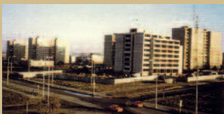
Stavba objektu ubytovny podniku KABLO v ulici Boloňská 478/1 v roce 1988
