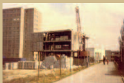
Stavba Kulturního domu Varta v místech bývalého dvora, rok 1986
