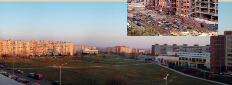
Výstavba objektů na Veronském náměstí v letech 2004–2005
