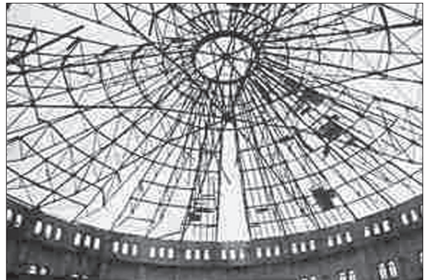
Gaskesselkuppel 1942 von innen
