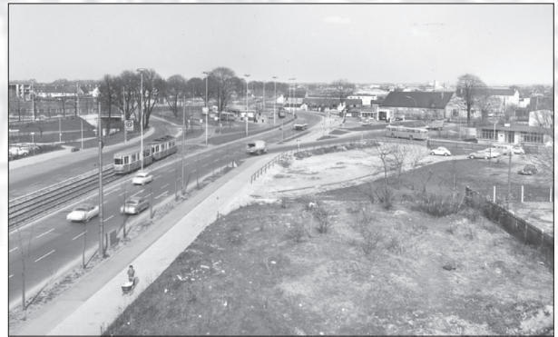
Vogelweideplatz nach Osten, Truderinger Straße zweigt ab
