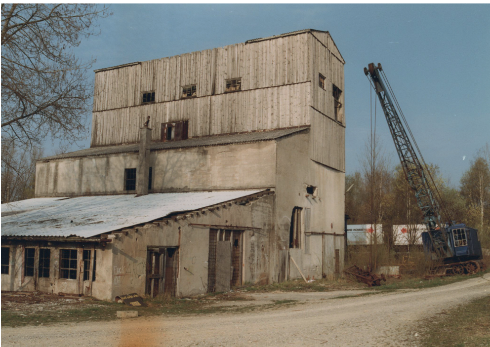
Die Reste des Kieswerks Obermaier (1999)
