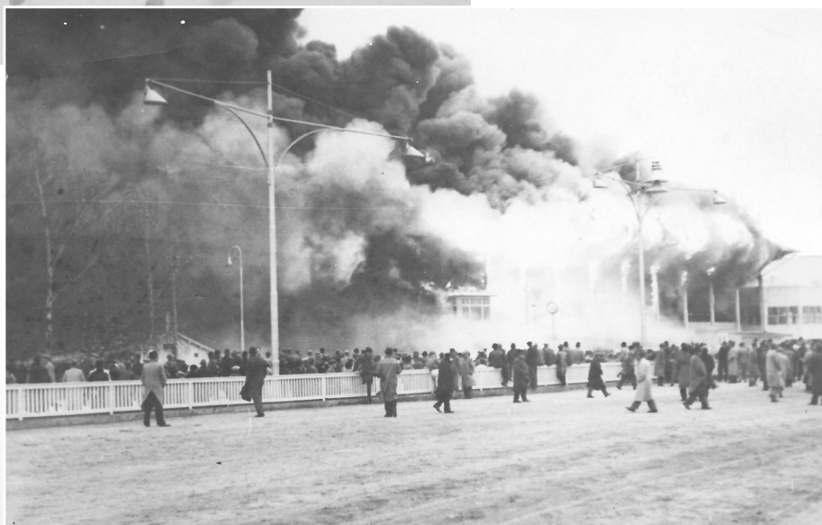
Brand der 1902 erbauten Haupttribüne am 3.4.1938, ausgelöst durch einen Kaminbrand
