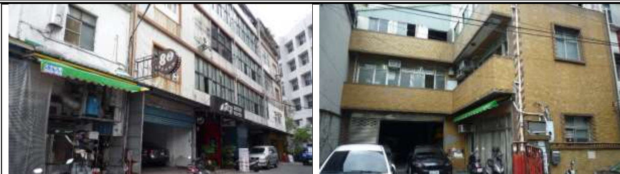
圖85 工2街廓內有許違規供住宅使用情形
