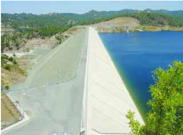
Το φράγμα Κανναβιούς σε λειτουργία
