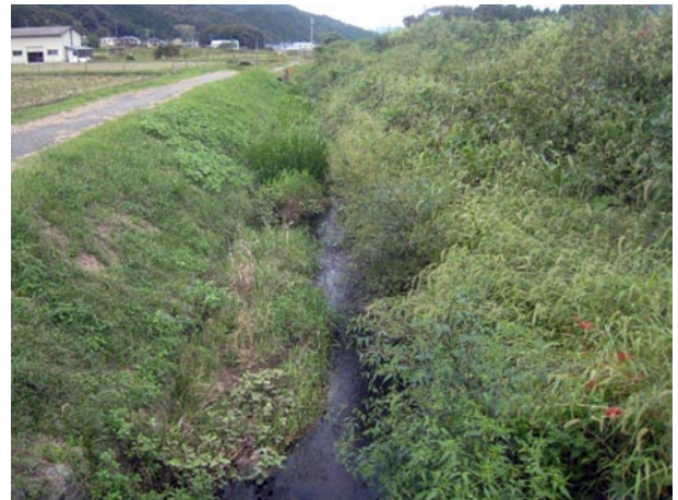
写真6 1年を経過したB水路⑤付近。(2010. 9)
