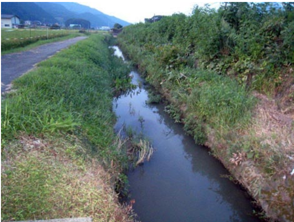
写真5 被災直後のB水路⑤付近。大きな影響を受けていない。(2009. 8)
