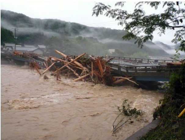
写真 13 円山川本流の被害. 朝来市内では円山川の橋梁が破壊された (山地災害の記録から)
