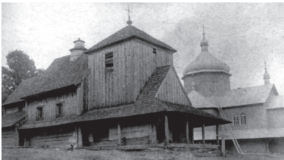
Ryc. 132. Żurawin. Cerkiew greckokatolicka z 1855 r. (w tle nowa cerkiew w budowie). Źródło: Kryciński S. 2005, s. 145.
