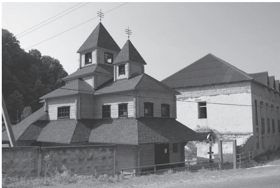
Fot. 48. Wołosianka – budowa nowej cerkwi greckokatolickiej (fot. G. Holly).
