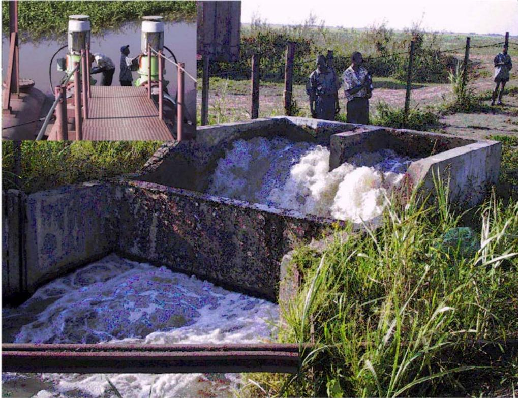
*Foto: Regadio da Açucareira de Sena - Local da descarga para o canal principal e Estação de bombagem flutuante instalada num canal que liga ao Rio Zambeze.*
