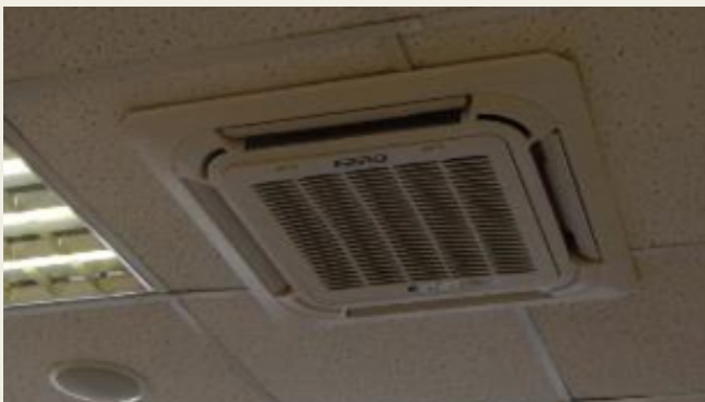
Fig. 22. 1: Fan coil; 2: Fan coil control panel
