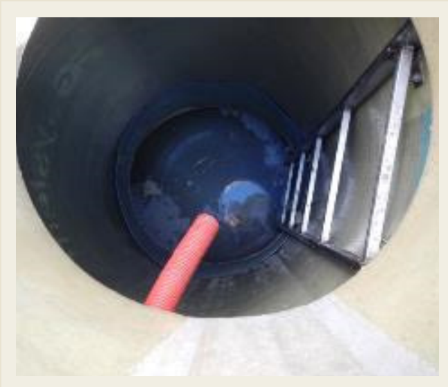
Fig. 30. Grease trap
