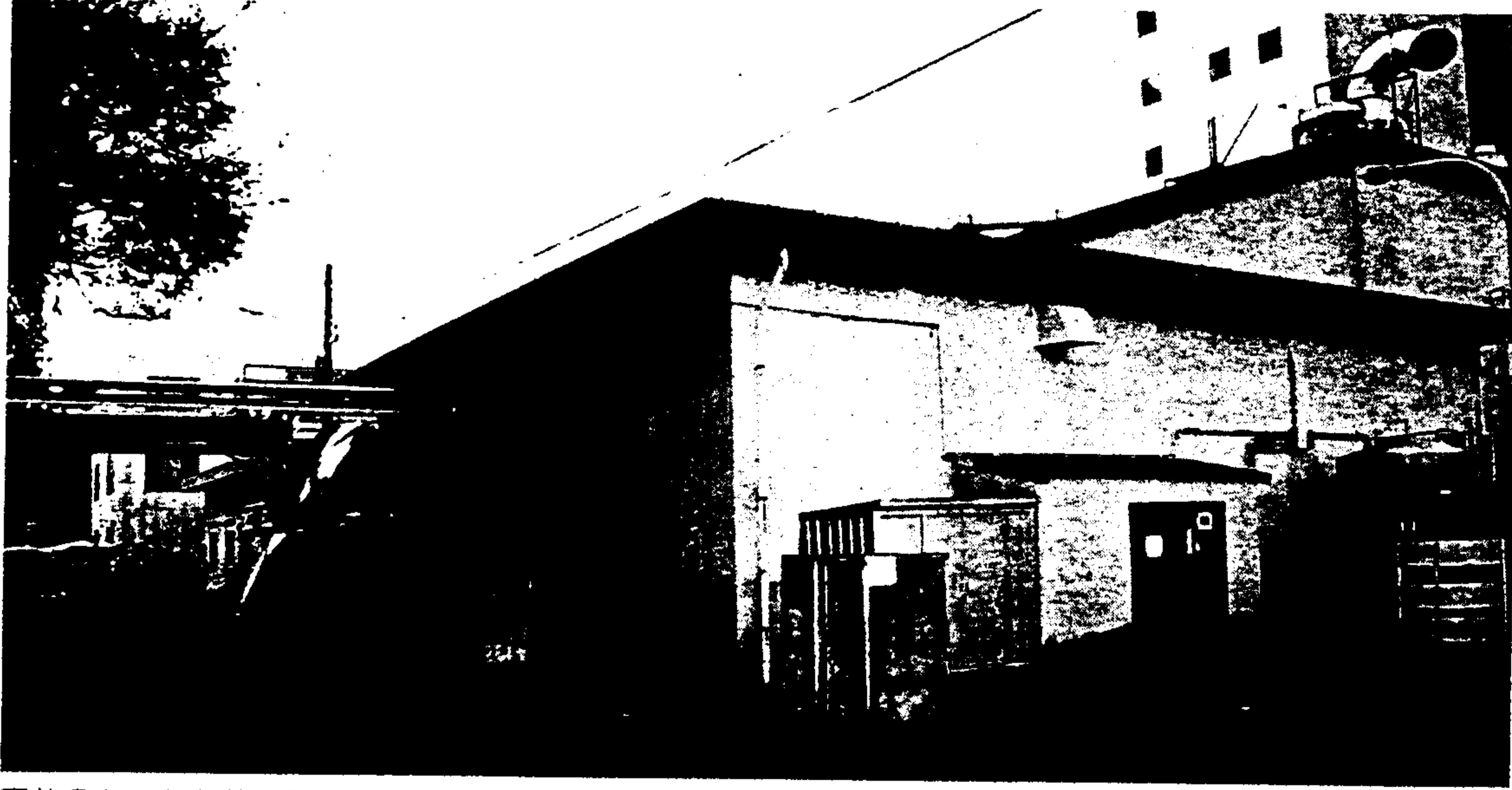
事故のあった転換試験棟。棟の周囲には、放射線を遮へいするため、コンクリートブロック（左の壁側）や土のう（左奥）が積まれています。（10月9日撮影）
