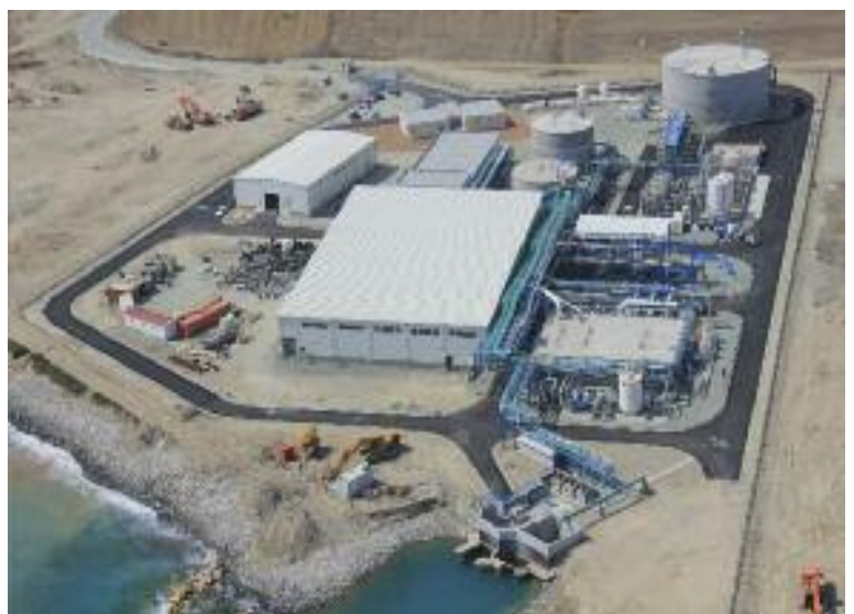
Μονάδα αφαλάτωσης Λεμεσού (Επισκοπής). (πηγή: Τμήμα Αναπτύξεως Υδάτων).
