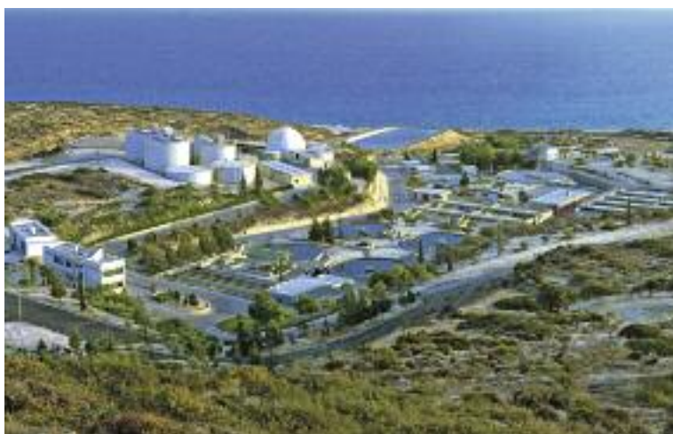
Σταθμός επεξεργασίας λυμάτων Λεμεσού-Αμαθούντας (πηγή: Τμήμα Αναπτύξεως Υδάτων).
