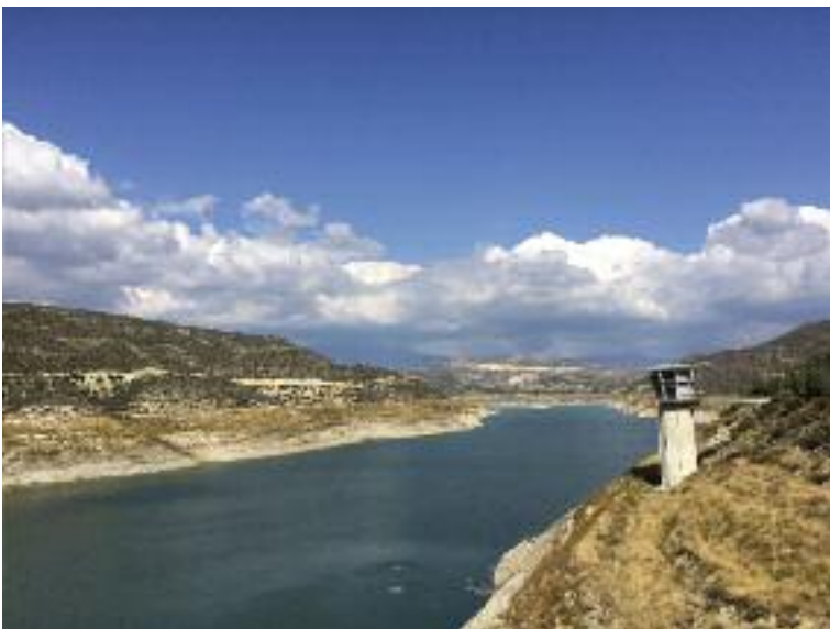
Το φράγμα Κούρη.
