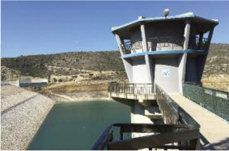
Το φράγμα Κούρη.
