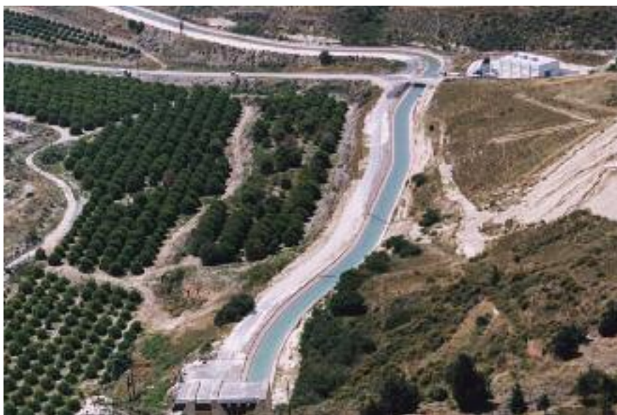
Ανοικτό κανάλι άρδευσης, Πάφος (πηγή: Τμήμα Αναπτύξεως Υδάτων).
