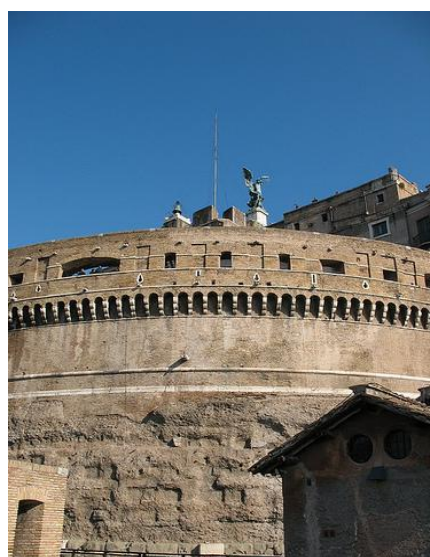
Parte inferior del edificio donde se observan restos del muro del mausoleo sin revestimiento.
