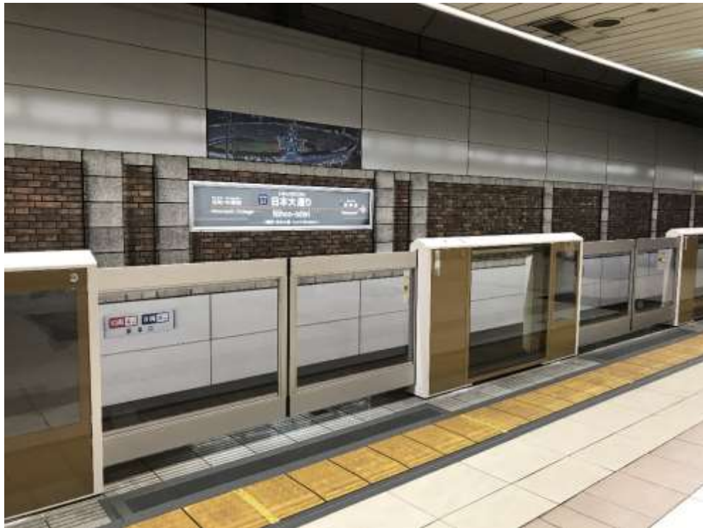
日本大通り駅可動式ホーム柵整備状況
