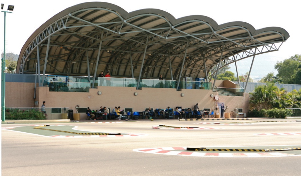
(4) 佐敦谷堆填區設有大型上蓋的無線電遙控模型車賽車場
