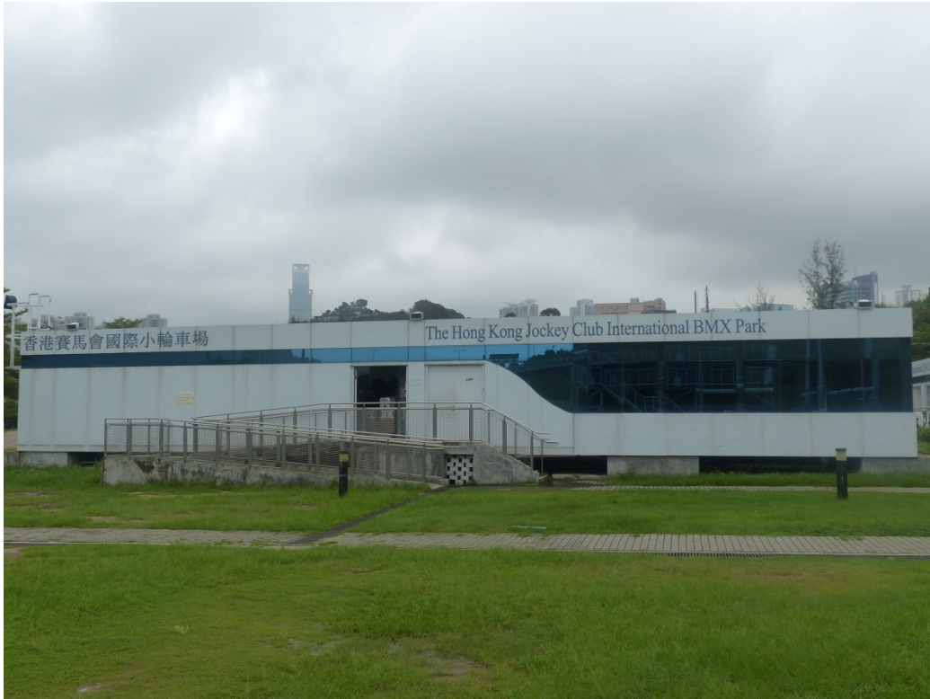
(1) 醉酒灣堆填區已架高的辦公大樓
