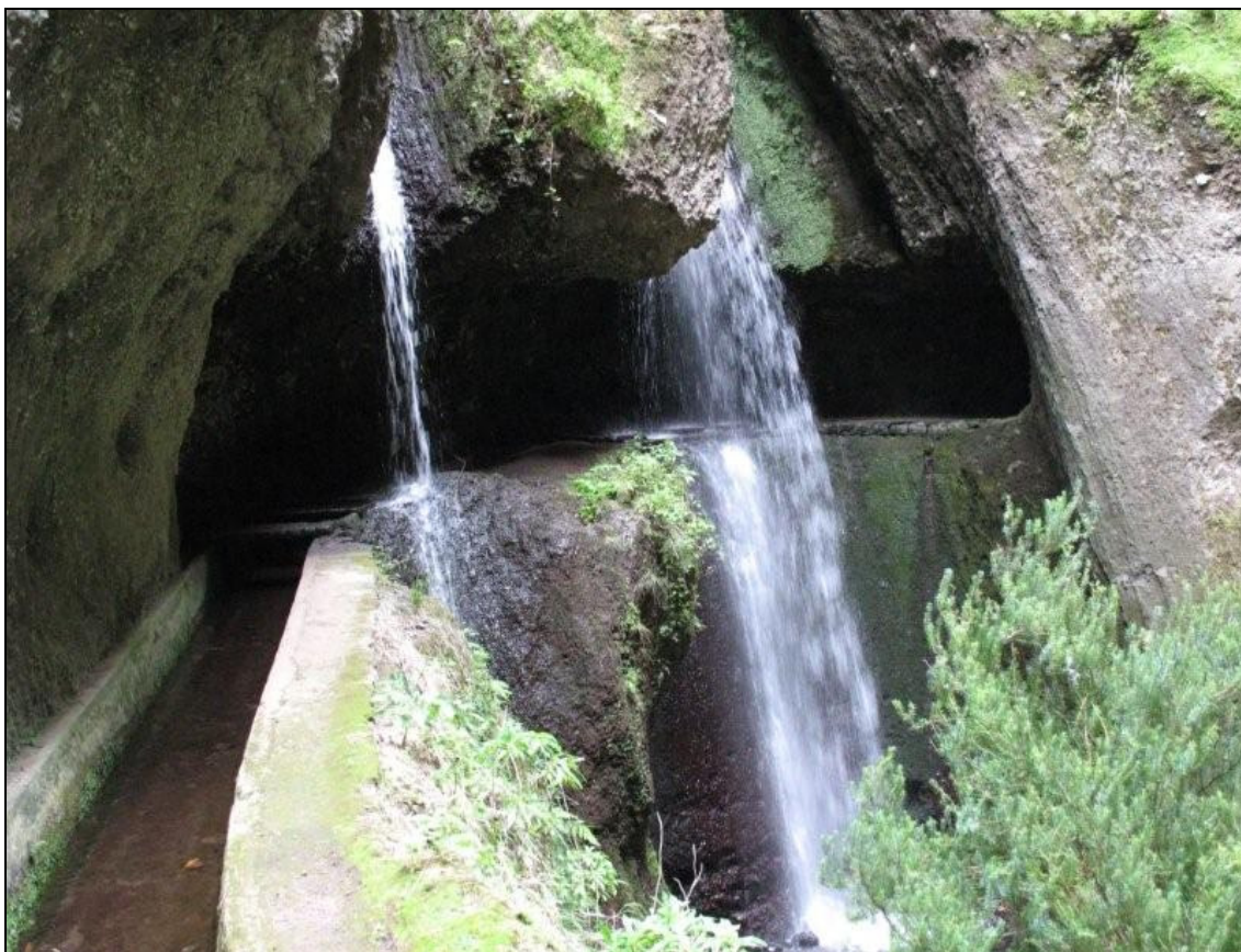
Figura 8 – Levada Nova na Lombada da Ponta do Sol (R Q - 13.01.07)
