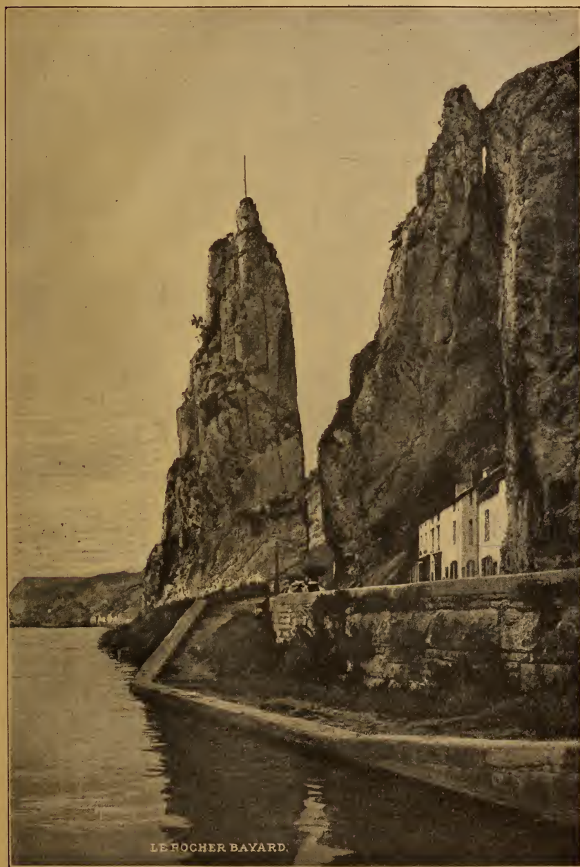
Emplacement du pont de bateaux construit par les troupes allemandes
