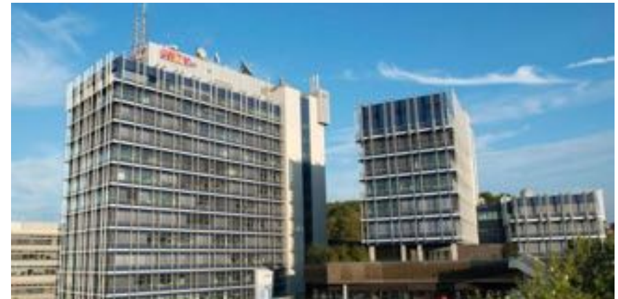
Sanierung Funkhaus A-Bau Stuttgart Projektkosten: 20 Mio. €
