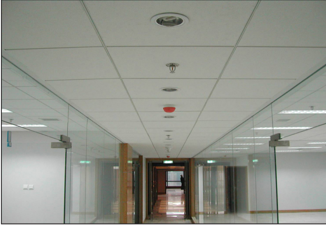
Foto 4: Panel asma tavan uygulaması
