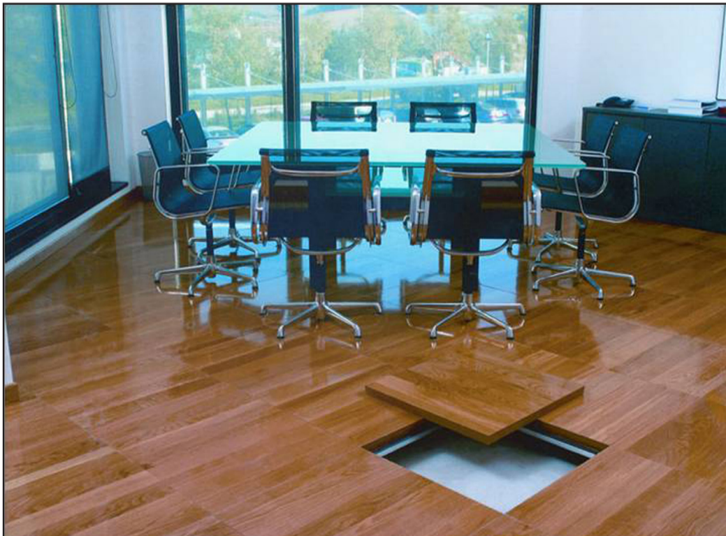
Foto 3: Yükseltilmiş döşeme uygulaması
