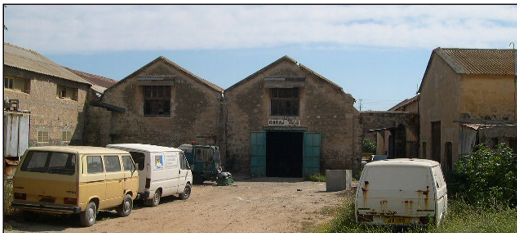
Yol cephesinin arka kısmı
