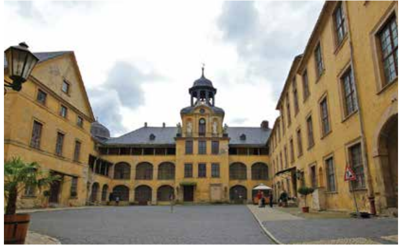
Das größte noch erhaltene Welfenschloss und Wahrzeichen der Stadt: das Große Schloss Blankenburg.
