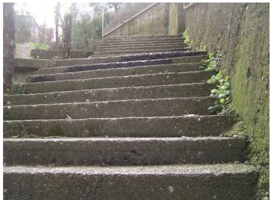
რკინა-ბეტონით ჩამოსხმული კიბე ფეხით მოსიარულეთათვის, ფოტო ნუგზარ მგელაძისა, მარტი, 2015 წელი.
