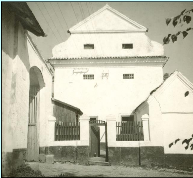
Průčelí zámeckého špýcharu z 50. let, kde téměř sto let bývala chotýšanská fara, později byt správce družstevního lihovaru Martina Koláře. 21)
