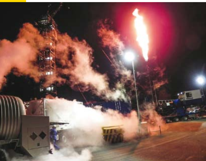
Bohrlochreinigung mit Abfackeln der Erdgasförderer Söhlingen Z14 von ExxonMobil in Niedersachsen, Foto: Bernd Ebeling
