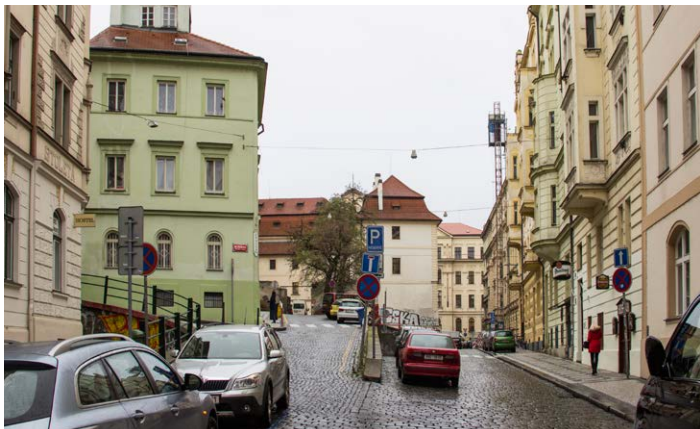
Stejný pohled dnes. Přestože okolo vyrostlo několik nových domů, ulice Na Zderaze si dodnes zachovala hodně ze svého starobylého rázu včetně velkých terénních rozdílů, které jsou vyrovnávány opěrnými zdmi
