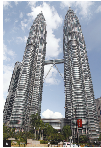
Рис. 2. Высотные здания, построенные с использованием высокоэффективных водопонижающих добавок: а — Скотиа Плаза, Торонто, Канада (фото публикуется с любезного разрешения Джона Бикли); б — строительство Ту Юнион-сквер, Сиэтл, США (фото публикуется с любезного разрешения Вестона Хестера); в — Башни Петронас, Куала-Лумпур, Малайзия (фото публикуется с любезного разрешения Morio и Wikimedia Commons)
