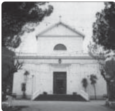
Casamicciola - Facciata esterna della nuova chiesa
