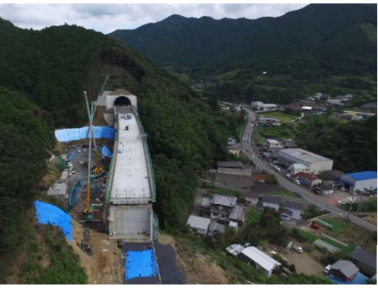
和田高架橋上部工事進捗状況 (平成30年9月上旬)
