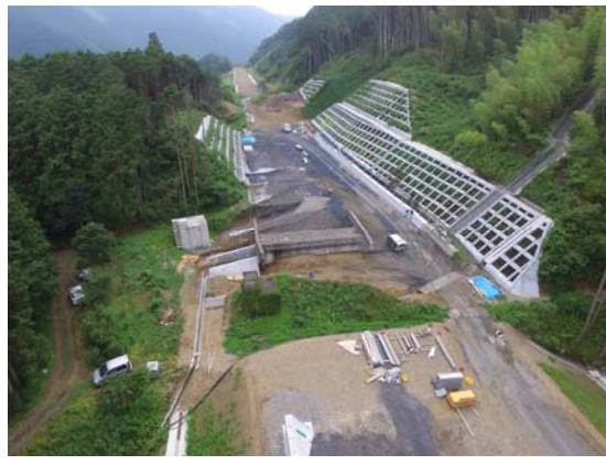
押ノ川地区改良工事進捗状況 (平成30年7月下旬)
