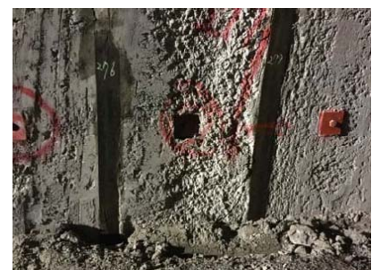
写真②: ロックボルト頭部の陥没
