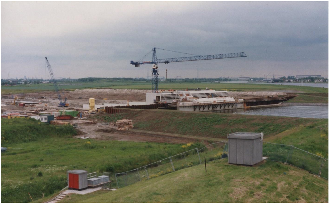
De Noordtunnel in aanbouw, gezien vanaf de Ambachtse kant. In het midden het dienstgebouw boven de tunnelingang.
