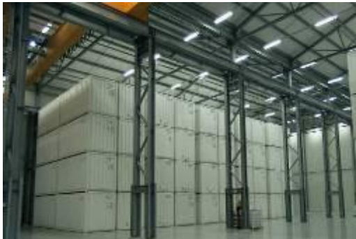
Figuur 7.6: Opslag van calcinaat in 20 ft containers in het container opslaggebouw
