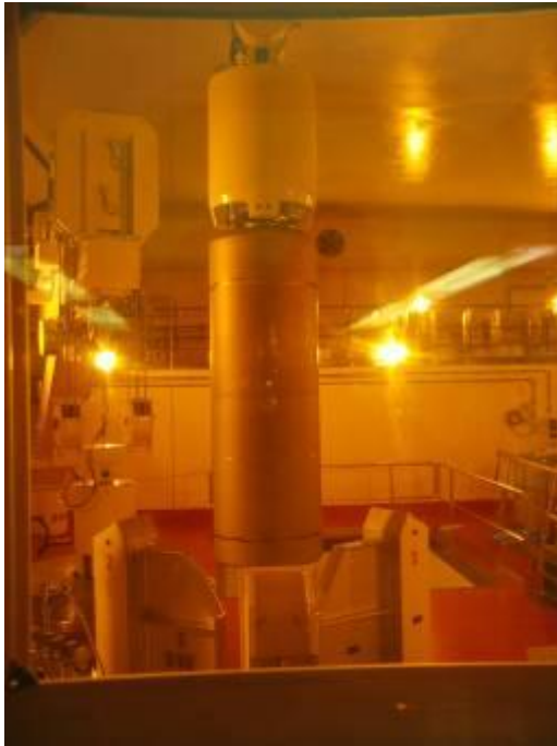
Figuur 8.6 : Het lichten van een opslagcontainer met de ontlaadkraan in de ontlaadruimte
