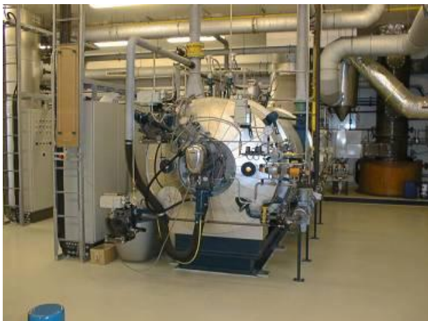
Figuur 6.7 : Vloeistofoven met rookgasreinigingsinstallatie
