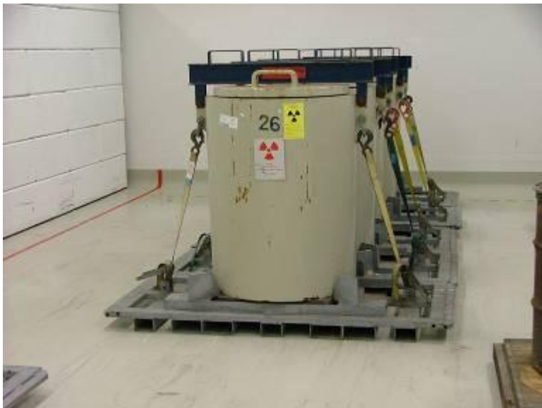
Figuur 6.15 : Transportcontainers voor afvalvloeistoffen van de molybdeenproductie
