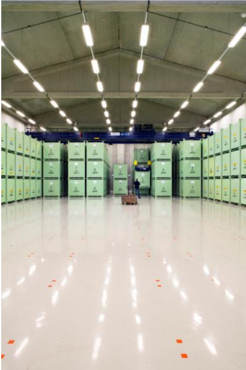
Figuur 7.5 : Opslag van verarmd uranium in het verarmd uranium opslaggebouw VOG1
