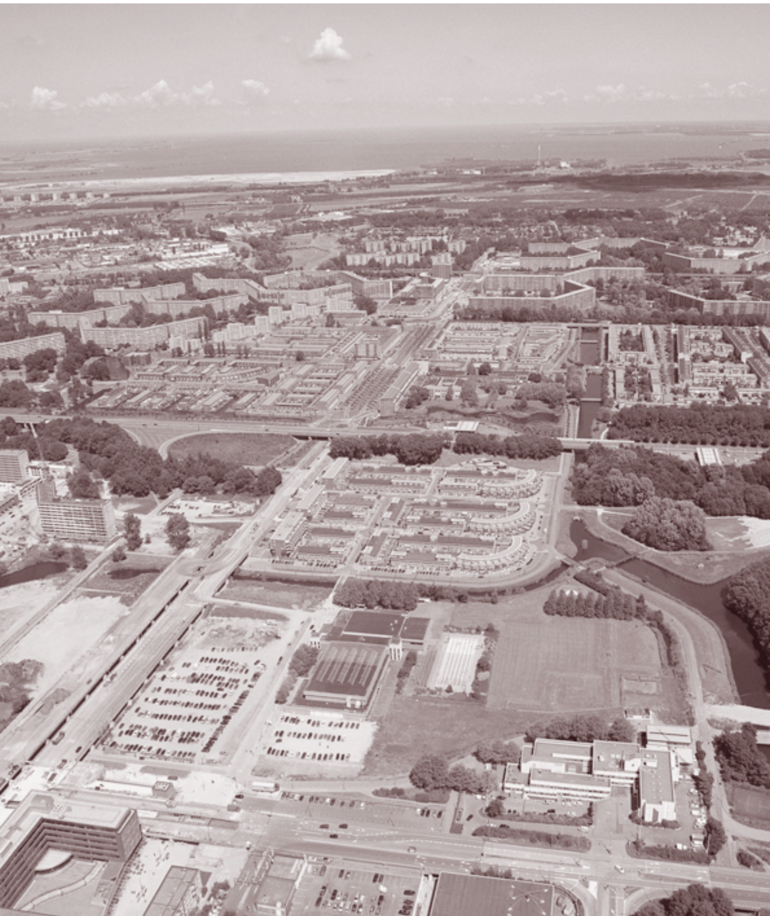
De herstructurering van de Bijlmermeer is een voorbeeld van een gebiedsgerichte ontwikkeling.
