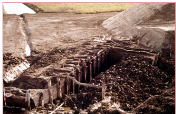
Afb. 9 - Een in Eiderstedt opgegraven dubbele paalwering/kistdam (Foto: H.J. Kühn, Archäologisches Landesamt Schleswig-Holstein, Schleswig)
