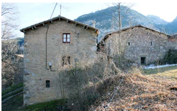
Façanes nord de P1 i A1 i façana sud de l'A2
