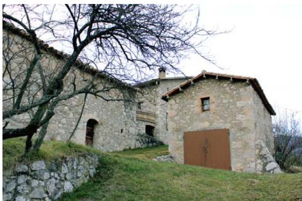
Façana sud de l'A1 i façana principal de P1
