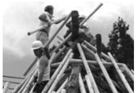
▲垂木を掛けています。これにより支柱が動かないようにしています。
