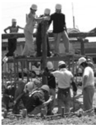
▲7月31日解体作業。ハシゴを使い茅を取り外している様子です。
