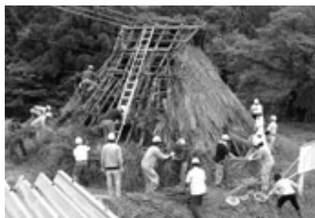
▲7月31日解体作業。ハシゴを使い茅を取り外している様子です。
