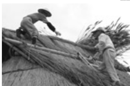
▲地元、高岡区の皆さんによる作業の様子。材料の茅を葺きやすいように小さく束ね直したり、茅葺のお手伝いなどをしていただきました。また、高岡区の女性のかたがたには作業期間中毎日、昼食時のみそ汁をつくっていただきました。ごちそうさまでした。
