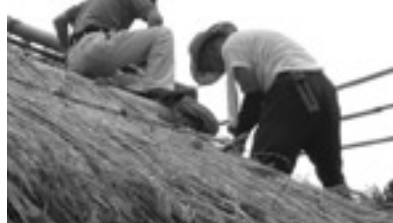
▲地元、高岡区の皆さんによる作業の様子。材料の茅を葺きやすいように小さく束ね直したり、茅葺のお手伝いなどをしていただきました。また、高岡区の女性のかたがたには作業期間中毎日、昼食時のみそ汁をつくっていただきました。ごちそうさまでした。
