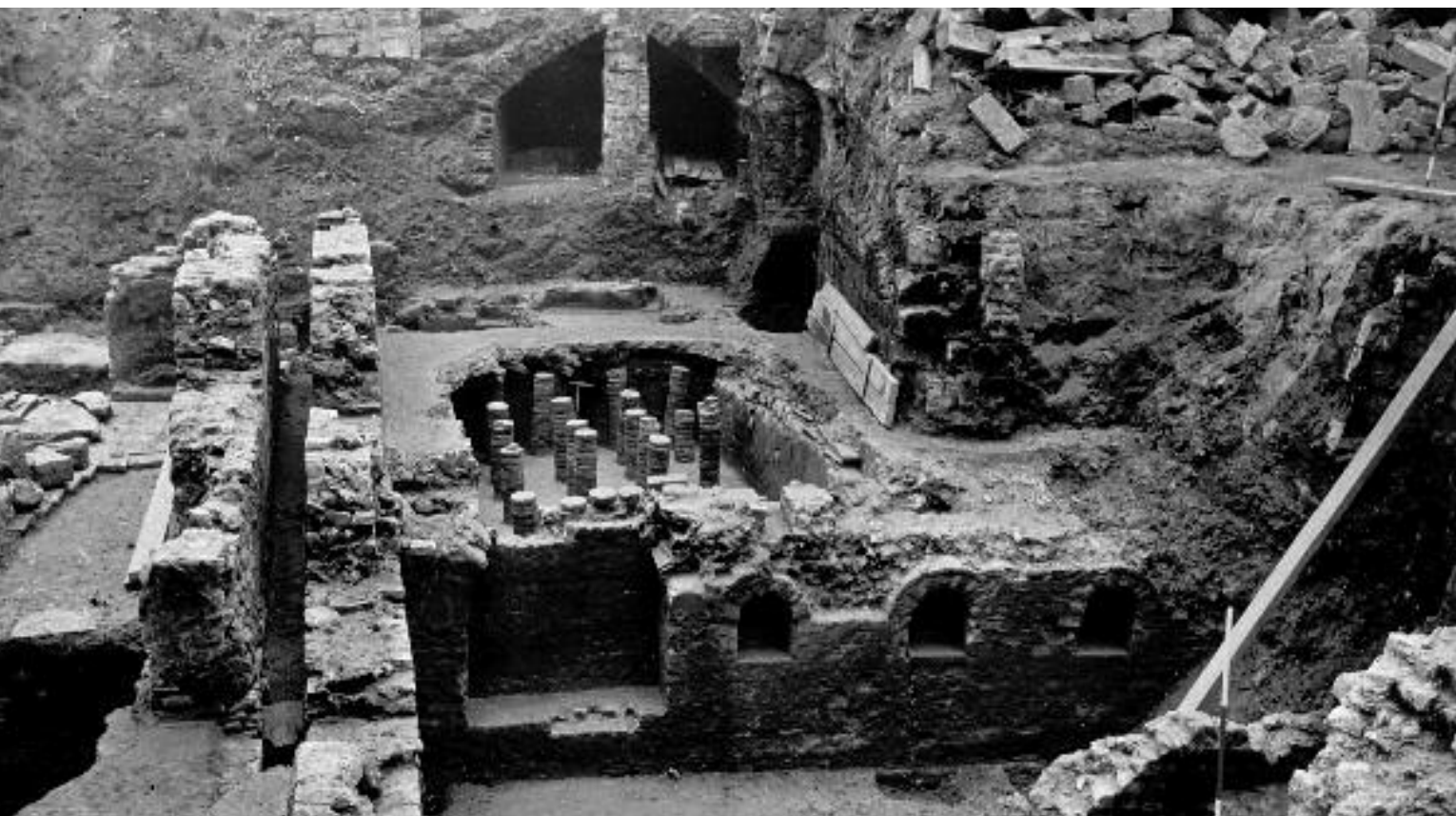
Het hypocaustum (badhuis) gevonden tijdens de opgravingen in 1963 op het daar naar genoemde plein Op de Thermen.
