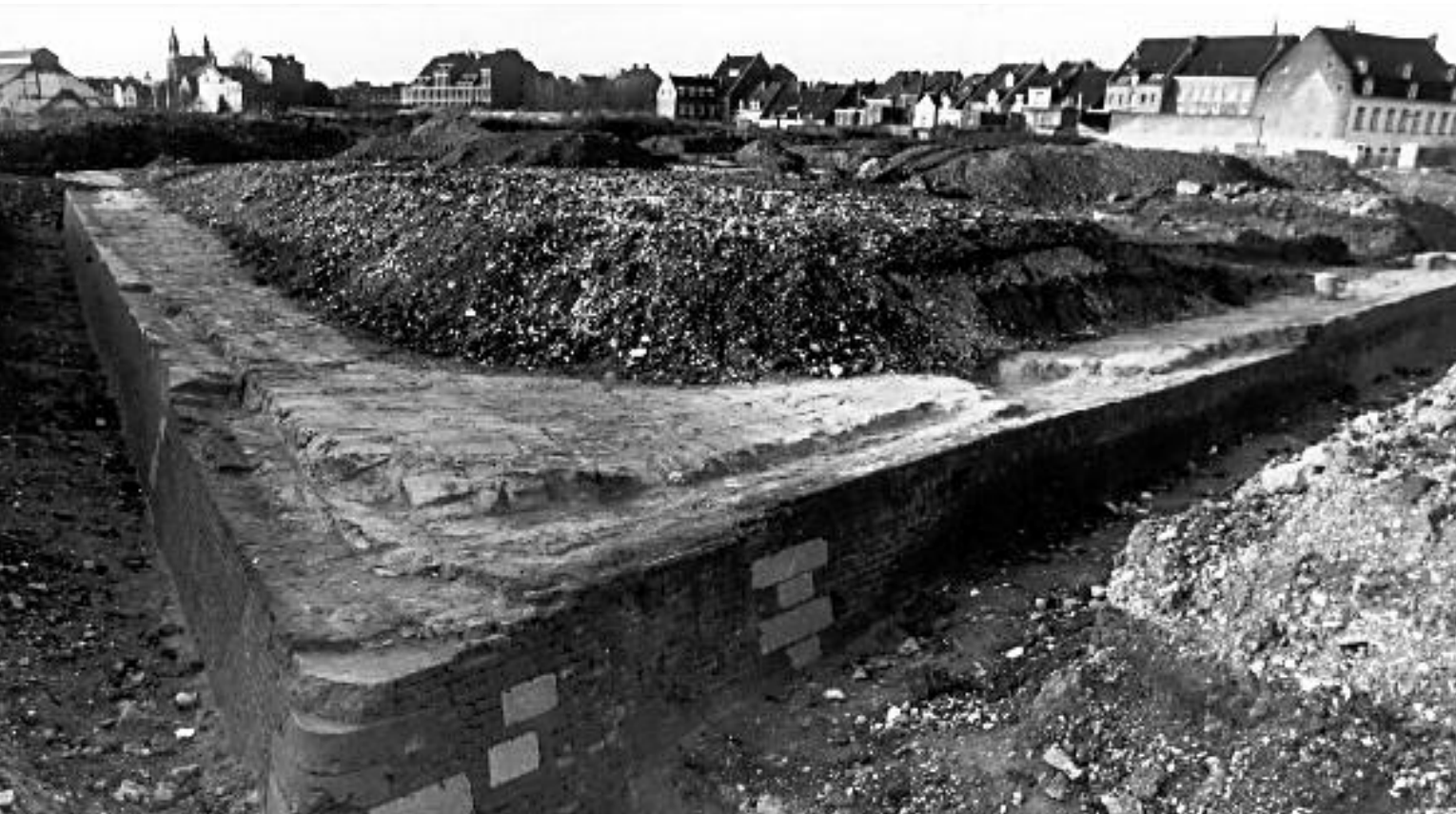
Aan de oostzijde van Maastricht, in Wyck, werd met de bouw van het Céramiqueterrein het fundament van het Parmabastion blootgelegd. Foto 1992.
