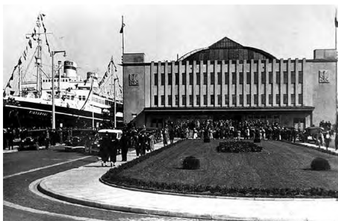
Ryc. 9. Dworzec Morski przy ul. Polskiej w Gdyni, zbudowany w 1933 r. wg projektu firmy „Dyckerhoff & Widmann” [Sołtysik M. 1993, s. 193]
