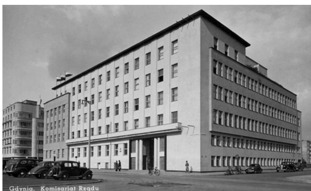
Ryc. 13. Komisariat Rządu przy al. Piłsudskiego w Gdyni, zbudowany w 1937 r. wg projektu Jerzego Müllera i Stefana Reychmana
