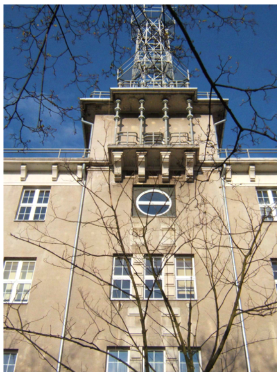
Ryc. 6. Państwowy Instytut Meteorologiczny przy ul. Waszyngtona w Gdyni, zbudowany w górnej części wg projektu Wacława Tomaszewskiego w 1929 r. (fot. M. Sołtysik)
