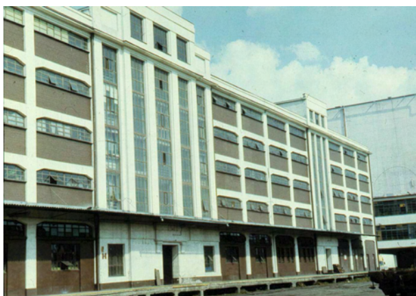
Ryc. 8. Magazyn Długoterminowy H przy ul. Polskiej w Gdyni, zbudowany w latach 1931–34 wg projektu firmy „Biuro Inżynierskie K. Jaskulski i K. Brygiewicz” (fot. M. Sołtysik)
