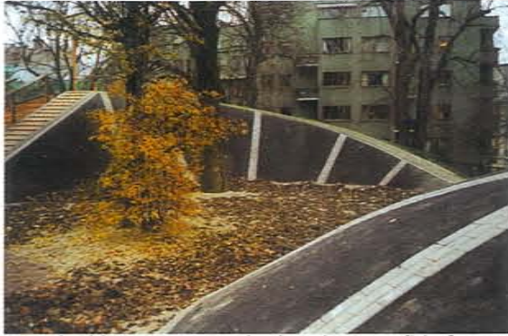
Overskuddsmasser er brukt i en fiskeformet terrengform med amfi, sklie, kongen-på-haugen og løpestreng.
