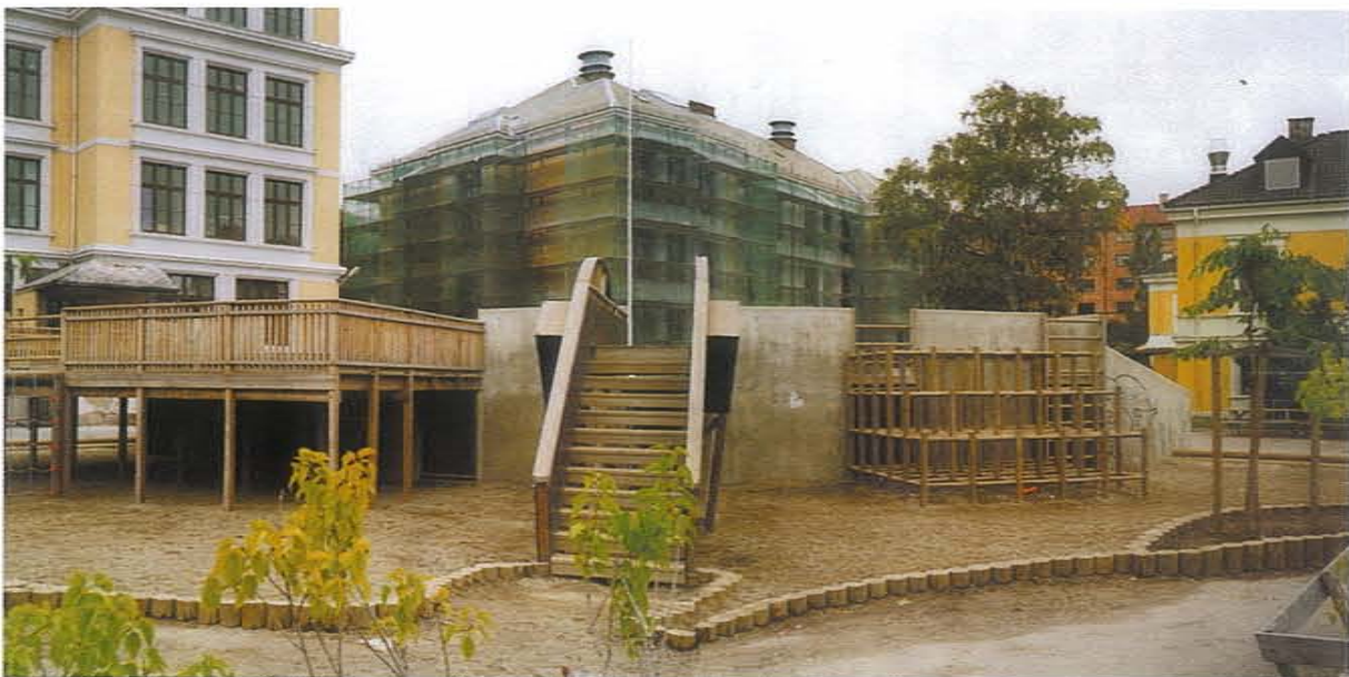
Betongkonstruksjonen fungerer som rygggrad for trappeløp, ribbevegger, sklie, klatrevegg, klatrenett og klatrekuber.
