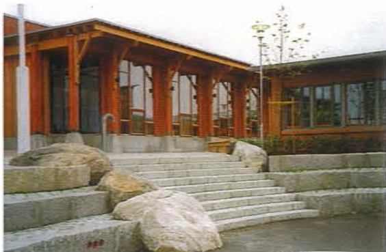
Dyrløkkåsen skole i Drøbak, Frogn kommune har en nivåforskjell mellom skolebygg og selve skolegården. Denne er utformet som et langsgående amfi i granitt, med trappeneanlegg og natursteiner integrert.
