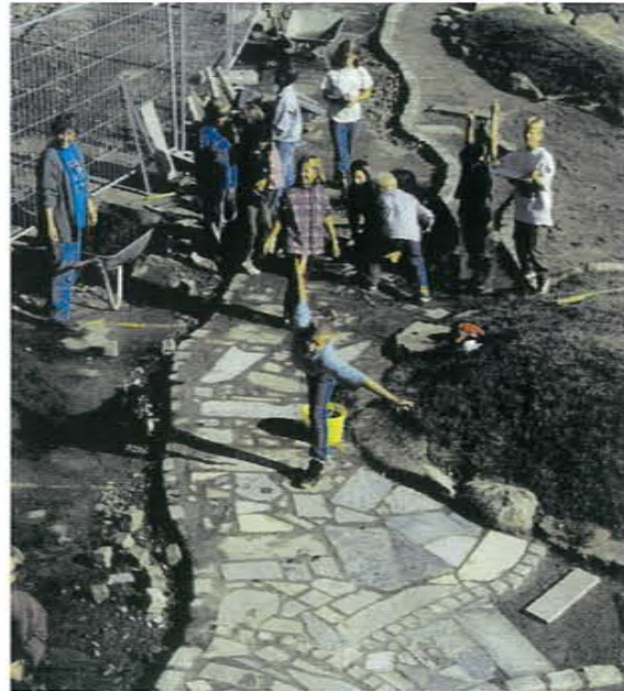
Gangvei laget på dugnad av steinrester fra en gravmonumentbedrift
