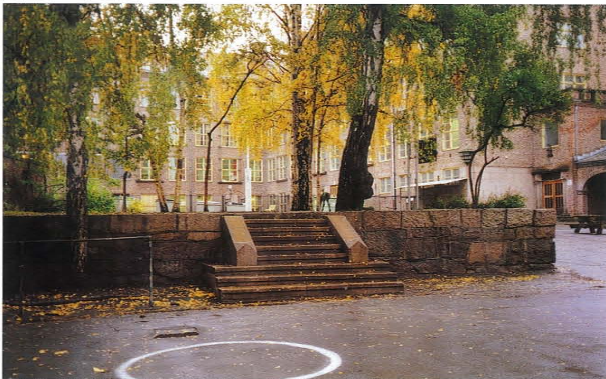
Ny trapp fra skolegård til tidligere skolehage. Gjenbruk av gamle granitt-trinn fra rivningsarbeider ved Hartvig Nissens skole
