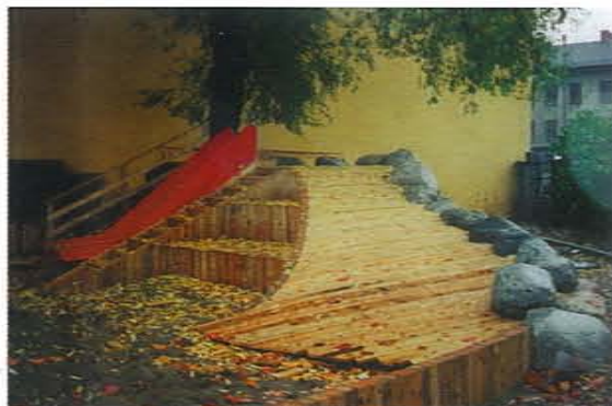
På Møllergata skole i Oslo er det utformet et lite amfi med rampe, trapper og sklie. Terrengformen blir holdt på plass av morenestein i bakkant. Disse kan brukes til å klatre og klyve på.
