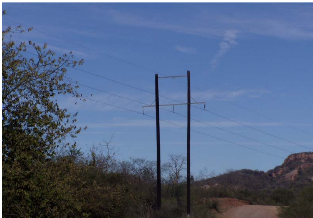
Foto II.1 Estructura tipo "H" en la línea eléctrica existente, en el tramo Maquipo- Chinal, municipio de Álamos, Sonora. Similar a la que se utilizará en la LST Presa Miguel Hidalgo-Cerro Colorado
