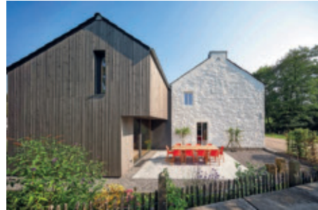
Vorbildliche Sanierung und Erweiterung eines alten Bruchsteinhauses in Aachen-Freund
