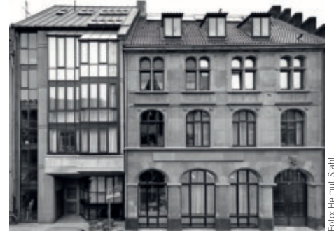
Büro- und Wohnhaus Rheingasse 16/14 von Walter von Lom, Köln 1974/1991
