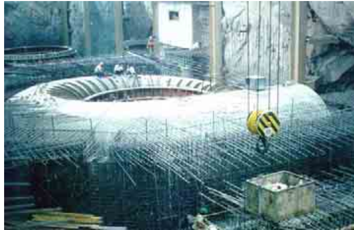
Figura 22. Proceso de revestimiento con concreto Armado de la carcasa del generador.
