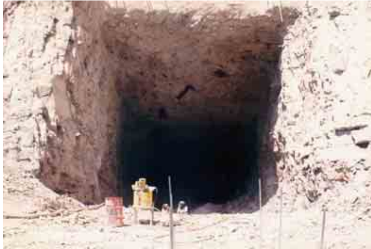
Figura 32. Excavación del tramo bocatoma – transición – codo superior.
