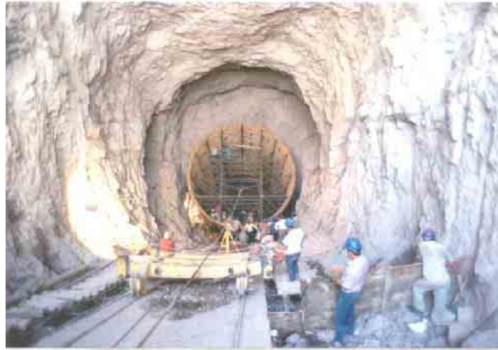
Figura 39. Colocación de cimbra para el colado del codo de la tubería a presión.
