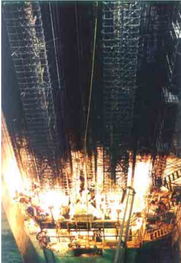
Figura 42. Colocación de acero de refuerzo y colado en las guías de compuertas en pozos. Nótese el proceso de deslizado.
