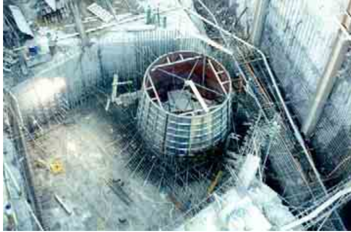
Figura 21. Proceso de armado y colado en foso del generador.
