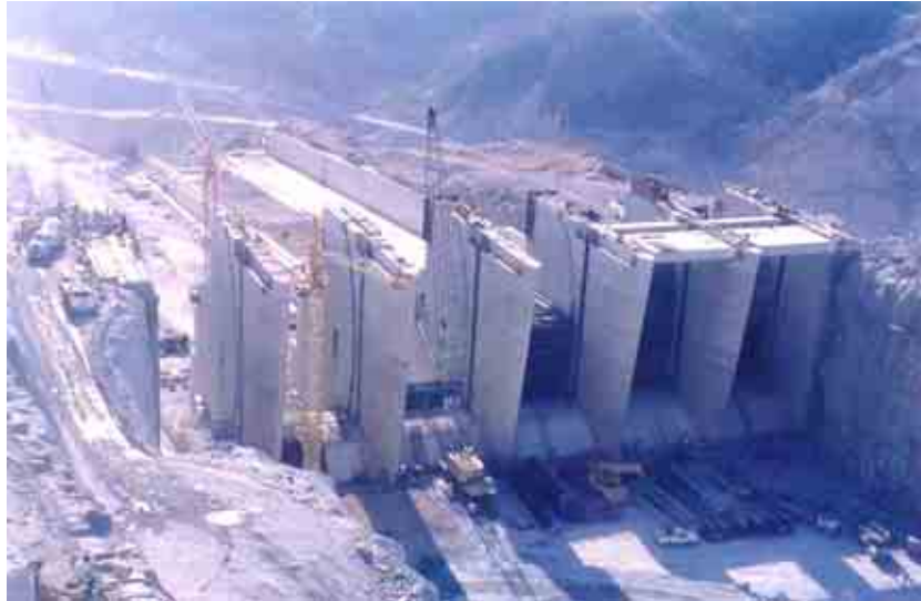
Figura 57. Proceso de revestimiento con concreto en estructura de control.
