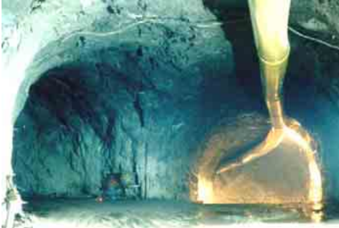
Figura 11. Excavación del túnel auxiliar a tuberías a presión y tímpano norte de casa de máquinas PH Aguamilpa, el proceso de excavación es muy similar al planteado en el PH La Yesca.
