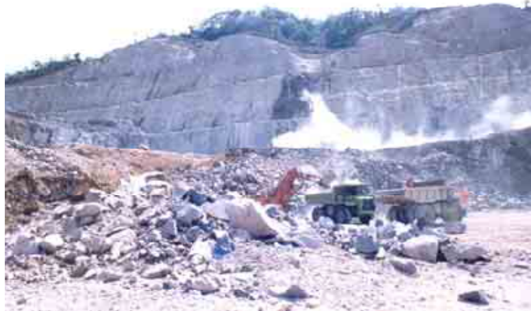
Figura 56. Excavación a cielo abierto de las obras de excedencias.
