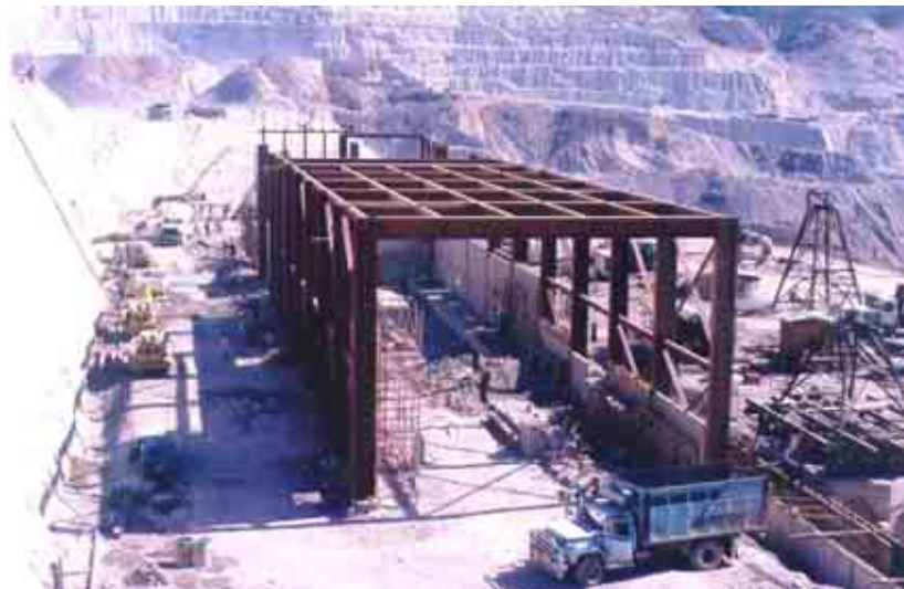
Figura 49. Estructura metálica en edificio de 400 kV de la subestación.
