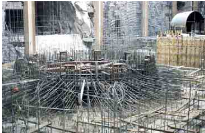
Figura 20. Proceso de colocación de acero de refuerzo en fosos de generadores.
