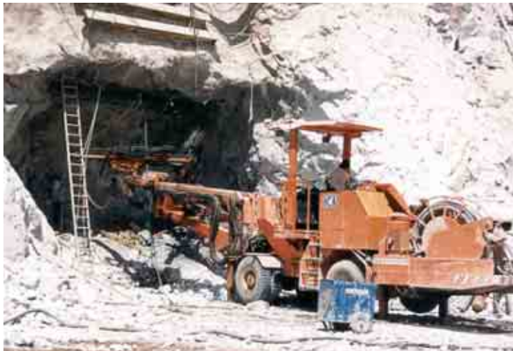
Figura 31. Proceso inicial de excavación de las bocatomas.
