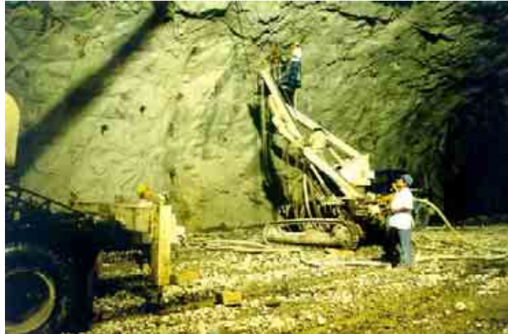
Figura 16. Colocación de anclas con track-drill en la bóveda de la caverna de casa de máquinas, proceso similar para el PH La Yesca.
