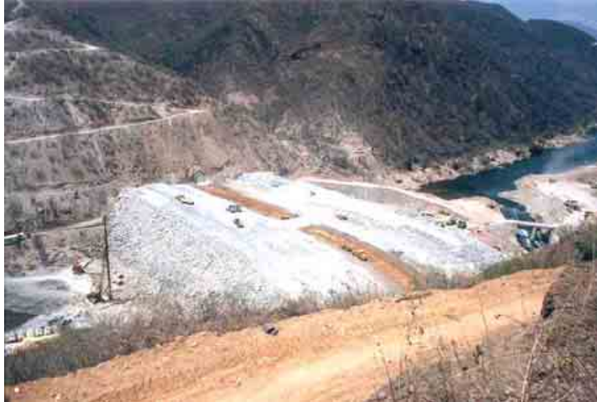
Figura 51. Ataguía de aguas arriba en proceso de construcción, formada con materiales graduados y corazón impermeable de arcilla.
