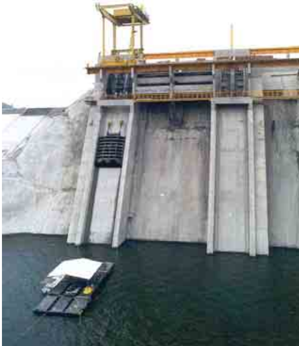
Figura 76. Izaje de compuerta auxiliar con apoyo de grúa pórtico.
