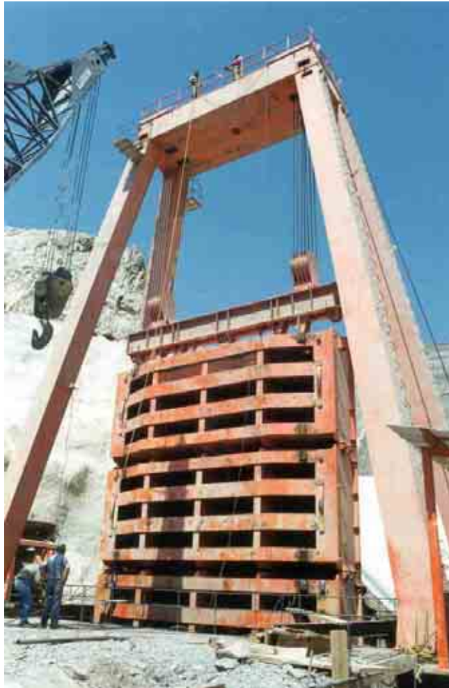
Figura 71. Proceso de armado en sitio de la compuerta de cierre final.
