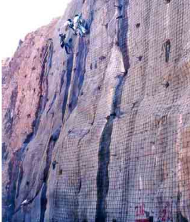
Figura 25. Tratamiento de taludes con mortero y malla electrosoldada.
