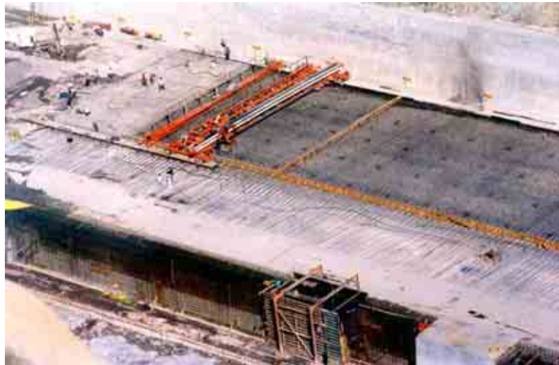
Figura 58. Cimbra deslizando en los concretos en zona del canal de descarga.
