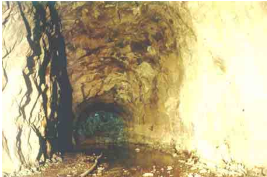
Figura 12. Excavación túnel piloto de aspiración. Al fondo se observa el foso de una de las unidades en casa de máquinas, proceso similar al planteado en el PH La Yesca.
