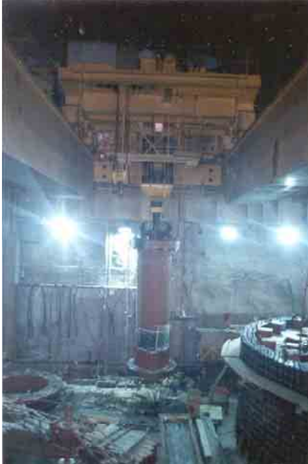
Figura 79. Montaje de flecha en una unidad de casa de máquinas, con apoyo de la grúa viajera.
