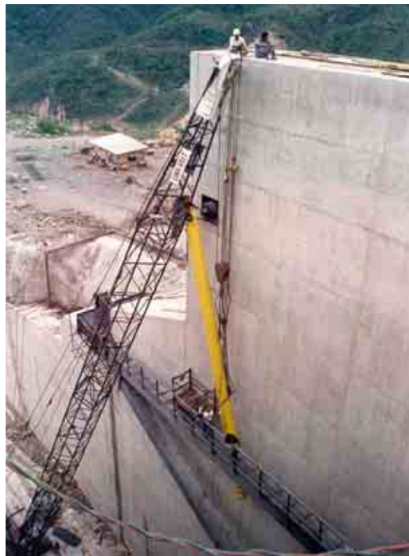
Figura 74. Proceso de montaje de los servomotores.
