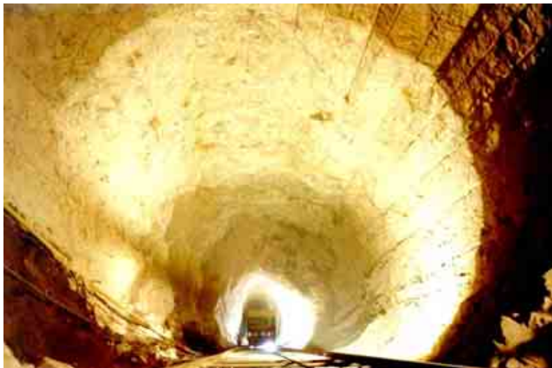
Figura 36. Excavación a sección completa en tuberías a presión.
