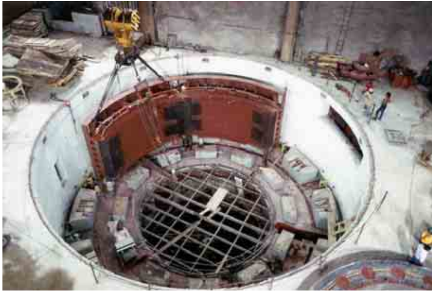
Figura 85. Colocación del segundo sector del estator dentro del foso.
