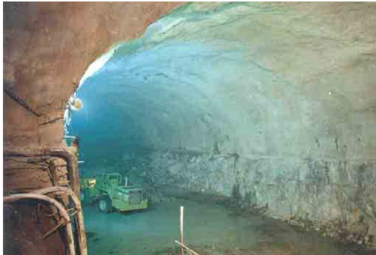
Figura 10. Excavación de banquetes de la caverna de casa de máquinas Etapa 3.
