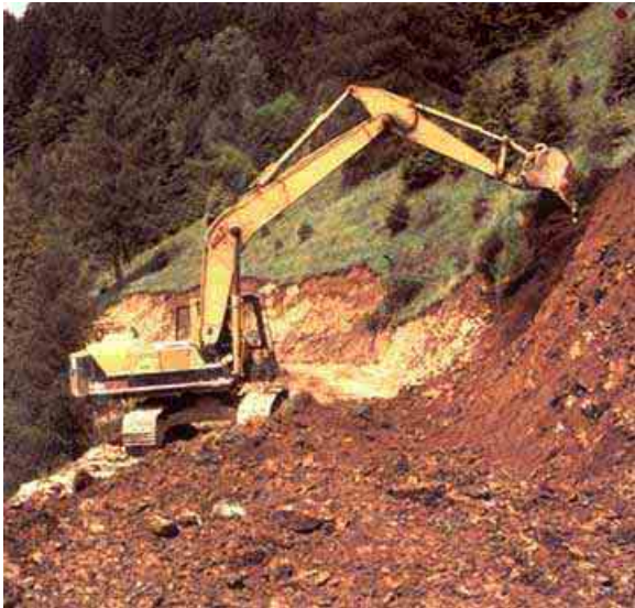
Figura 2. Maquinaria pesada conformando un camino.
