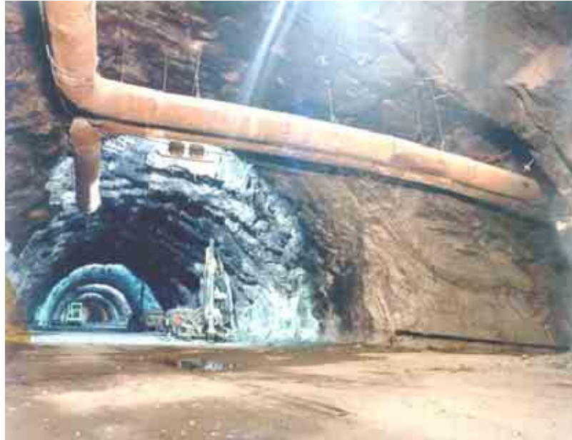
Figura 50. Media sección superior del túnel de desvío y bifurcación hacia el túnel crucero.
