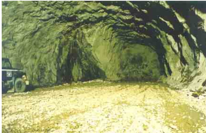
Figura 41. Excavación de la galería para izaje de compuertas.
