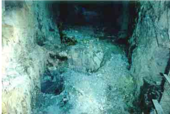
Figura 14. Excavación de los fosos de las unidades de casa de máquinas, proceso similar al planteado en el PH La Yesca.
