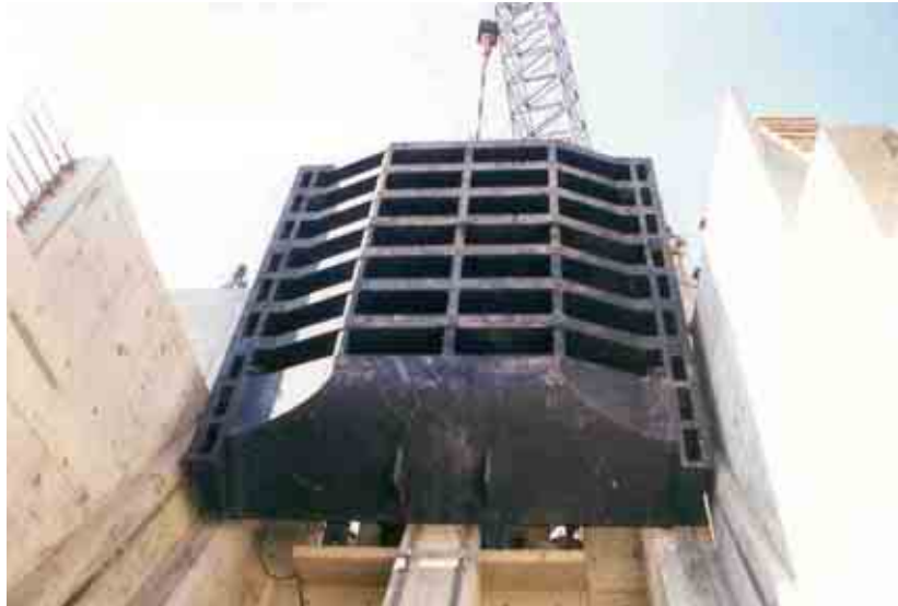
Figura 75. Proceso de montaje de compuerta de servicio sobre viguetas móviles.
