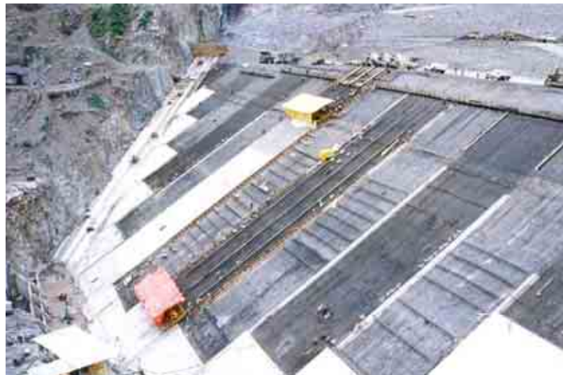
Figura 65. Proceso de construcción de la cara de concreto con uso de cimbras deslizantes, ollas revolvedoras para el suministro del concreto y canales para el llenado de la cimbra.
