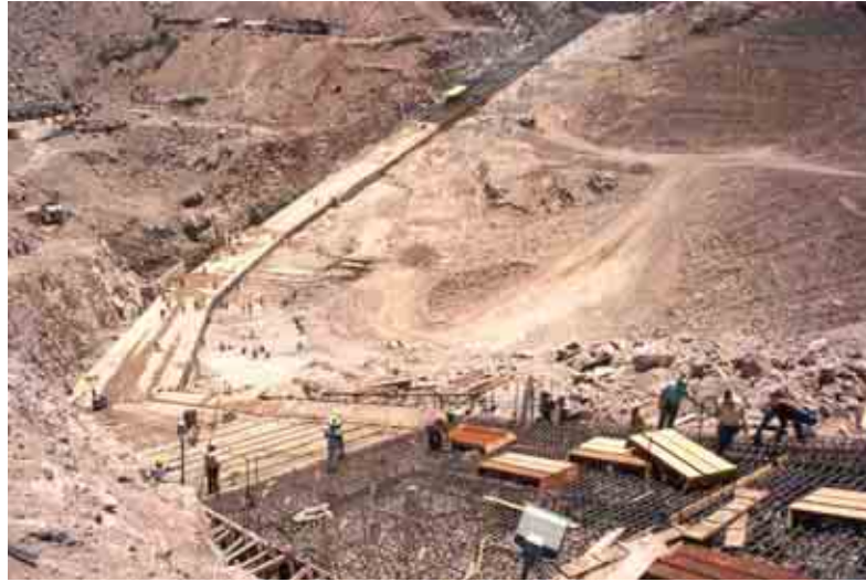
Figura 64. Proceso de construcción de la losa perimetral del plinto. Nótese la colocación del acero de refuerzo en ambas márgenes.
