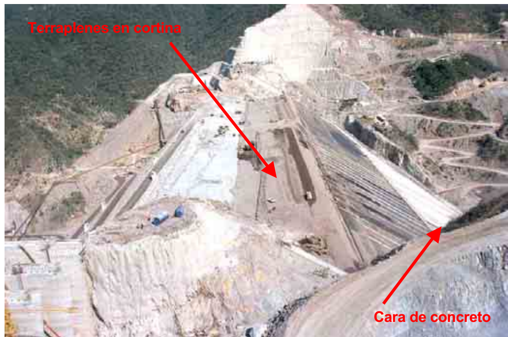
Figura 63. Formación de terraplenes en la cortina. Nótese el proceso de construcción de la cara de concreto de forma simultánea.
