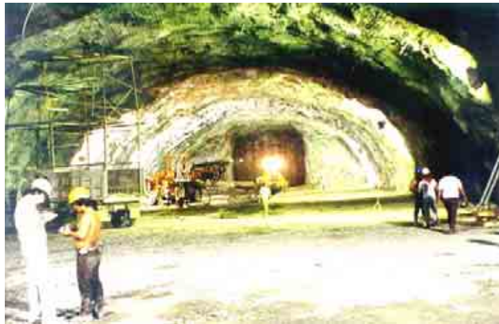
Figura 9. Excavación de la bóveda de la caverna de casa de máquinas del PH Aguamilpa, las dimensiones y el proceso de excavación es muy similar al planteado en el PH La Yesca.
