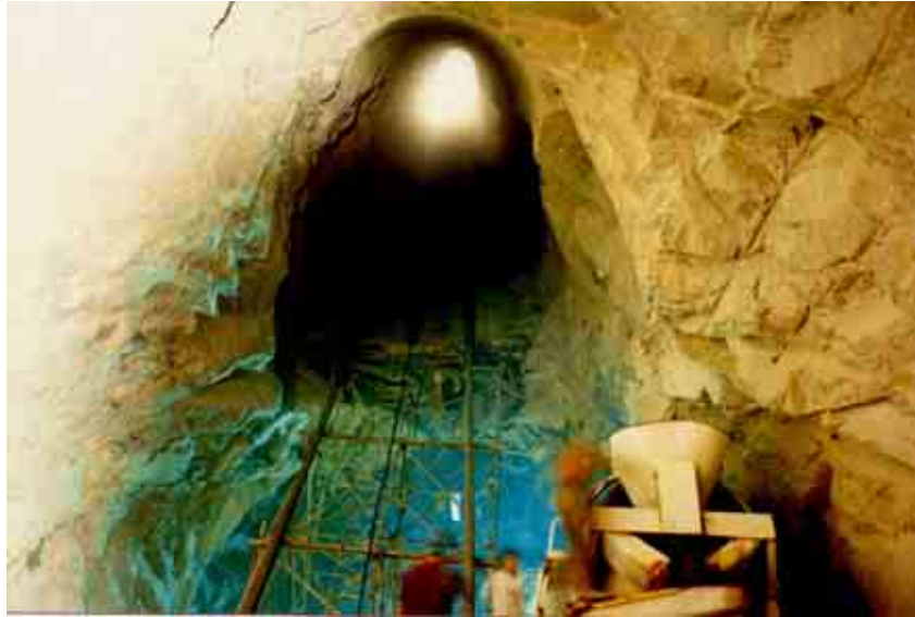
Figura 35. Ampliación del pozo piloto de las tuberías a presión.
