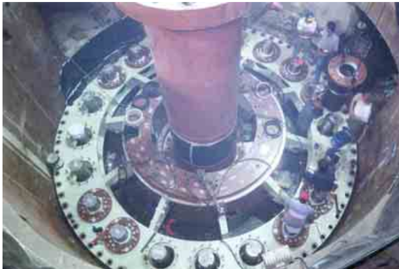
Figura 84. Colocación de la tapa de la turbina, la flecha de la turbina y la colocación de los cojinetes superiores de los álabes móviles.
