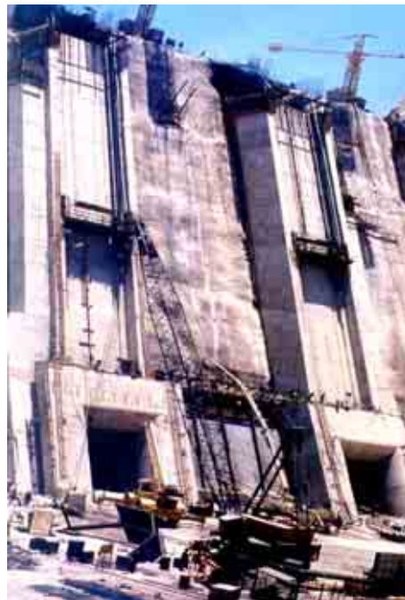
Figura 28. Revestimiento con concreto armado en bocatomas y torres de compuertas.
