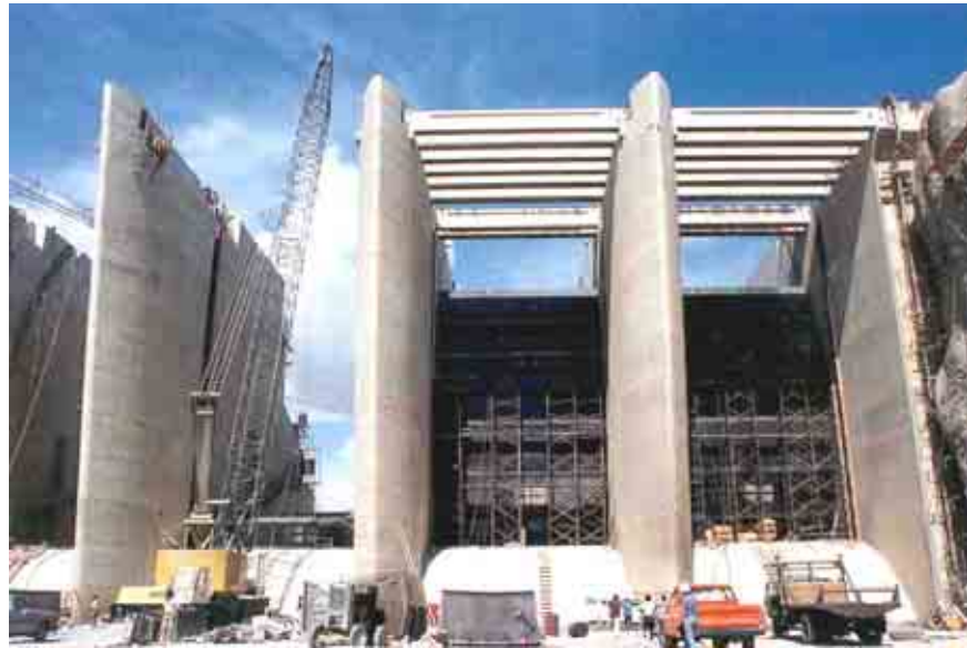
Figura 73. Montaje de las compuertas radiales.
