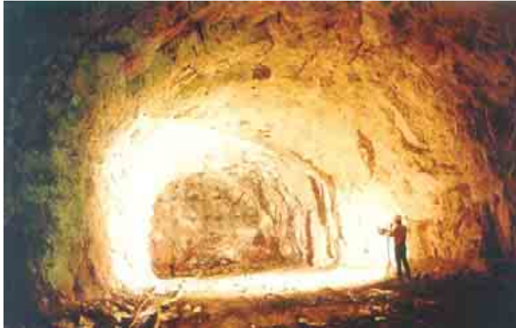
Figura 30. Túnel de acceso auxiliar a tuberías a presión.
