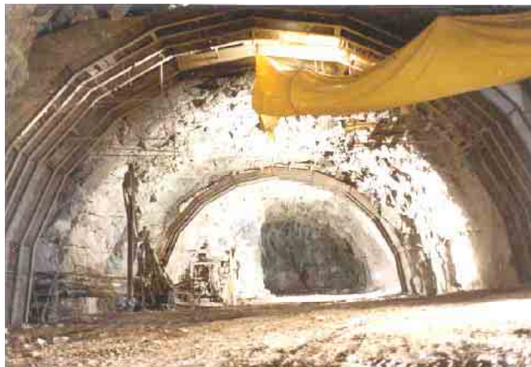
Figura 44. Excavación de la bóveda del túnel de desfogue.
