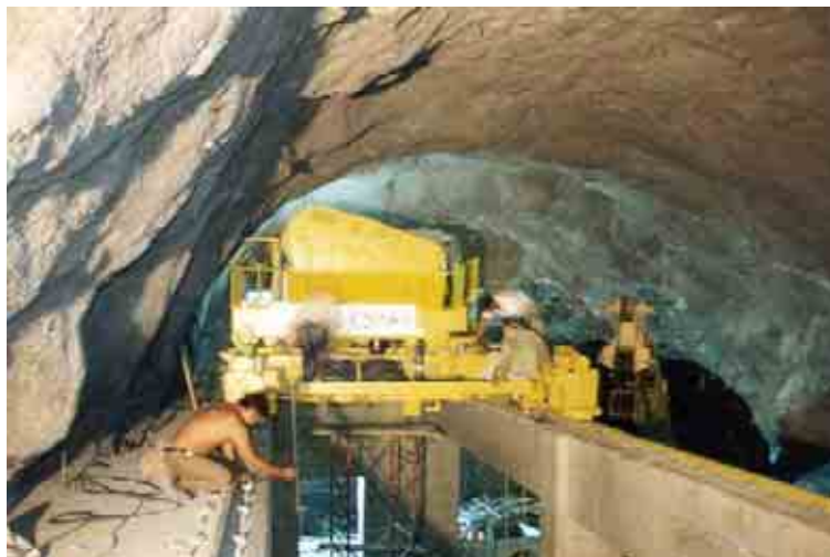
Figura 77. Montaje del carro de la grúa pórtico sobre travesaños.
