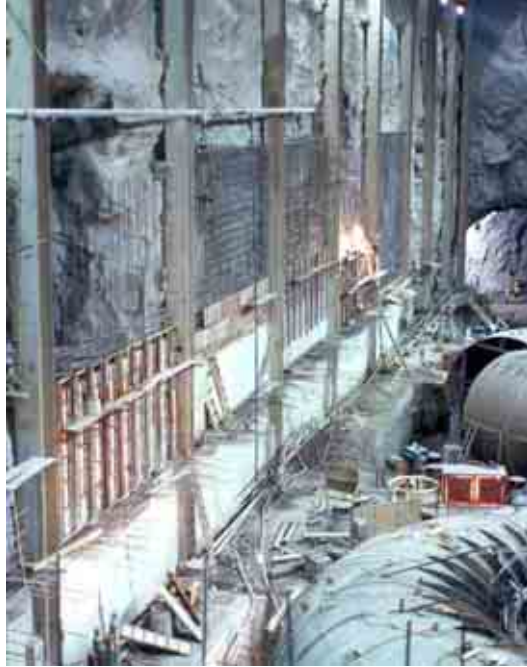
Figura 19. Revestimiento con concreto en paredes laterales de la casa de máquinas.
