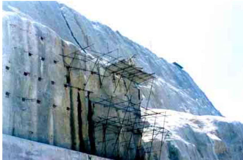
Figura 26. Revestimiento de mortero lanzado y soporte por medio de anclaje.
