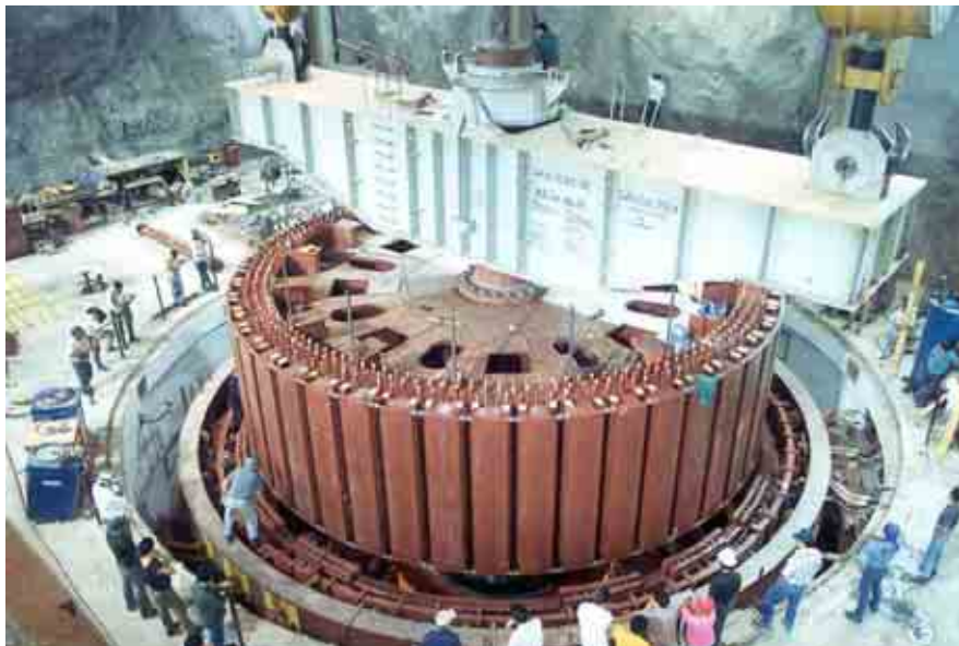
Figura 86. Colocación del rotor dentro del foso.
