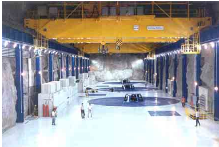
Figura 88. Vista general de casa de máquinas.
