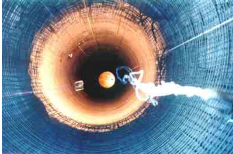
Figura 48. Colocación de acero de refuerzo para el revestimiento con concreto en lumbreras.
