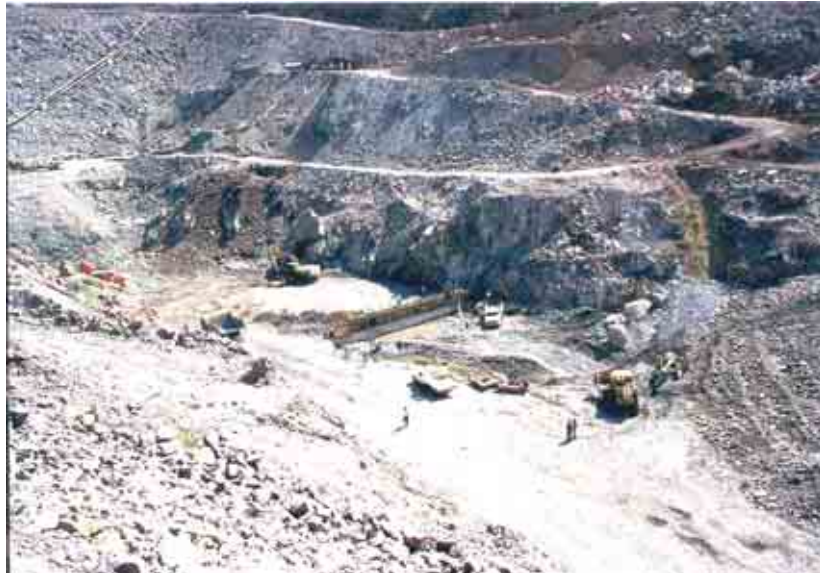
Figura 62. Proceso de construcción del cárcamo de bombeo y limpieza del recinto de la cortina con retroexcavadoras.
