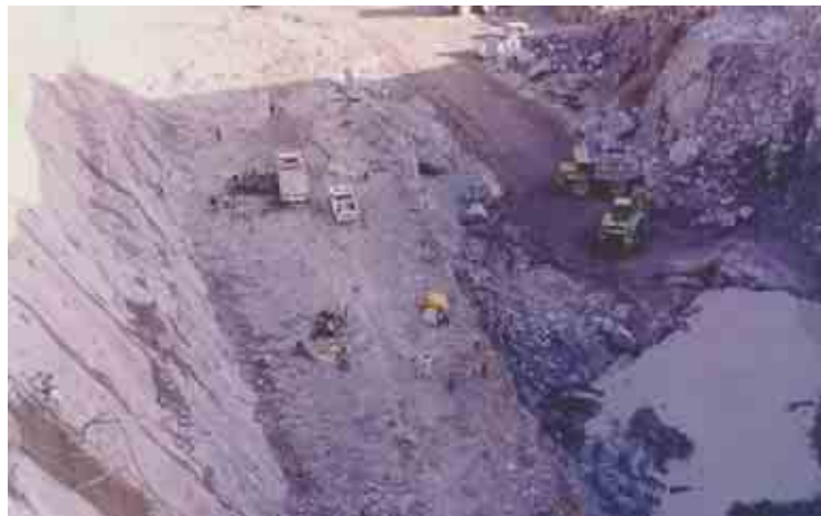
Figura 24. Excavación del canal de llamada de la obra de toma.
