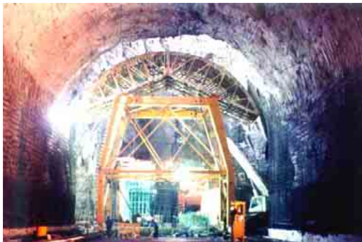
Figura 46. Montaje de piezas centrales para colado de la clave del túnel.
