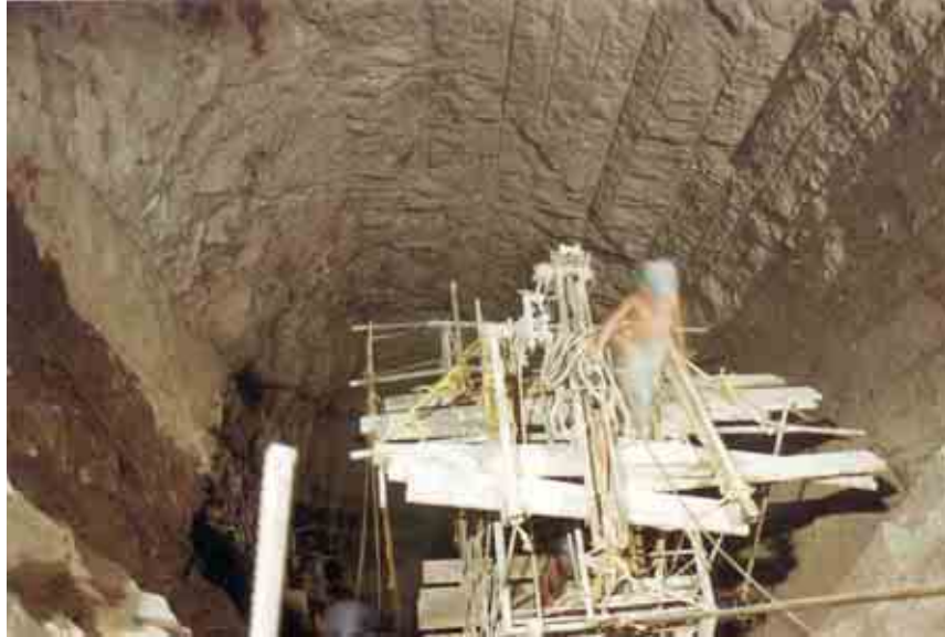
Figura 37. Tratamientos de la roca en tuberías a presión, mediante uso de track-drill montado en plataforma.
