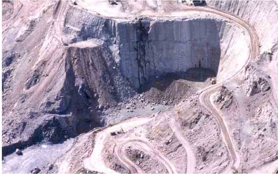
Figura 23. Excavación de la obra de toma.
